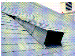
Chiroptière réalisée avec l'appui du Service technique provincial du Luxembourg à l'église de Nobressart (photo : J. Fairon)
