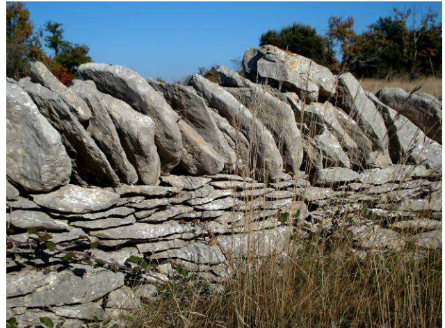
Un muret de pierres sèches en garrigue (S. L'Hostis)
