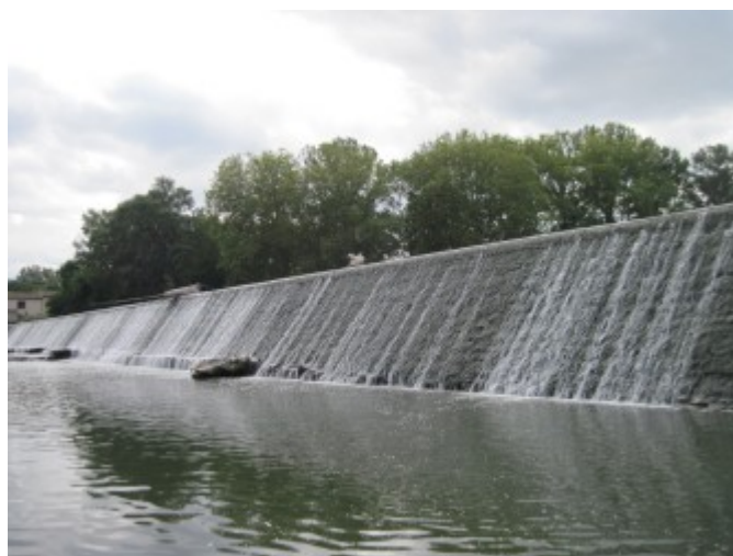
Fosse d'affouillement située en aval de l'ouvrage (photo BRLi, 2013)
