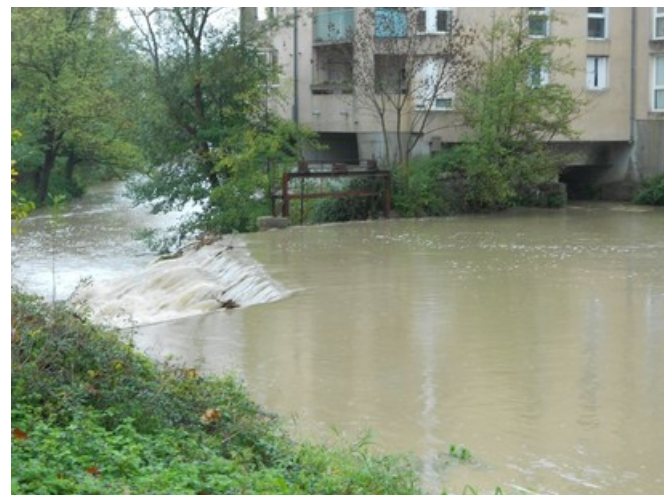
seuil du Moulin du Roy (Photo DDTM 11)
