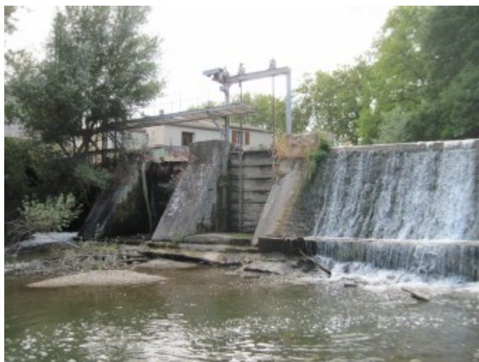
Vanne de vidange, rive droite (photo BRLi, 2013)
