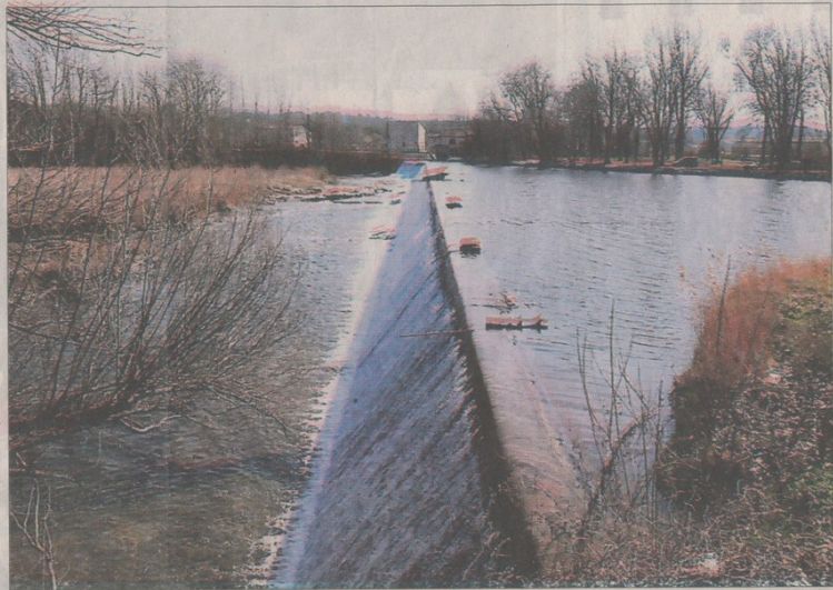
Des travaux nécessaires pour préserver le site du Païchéro.
