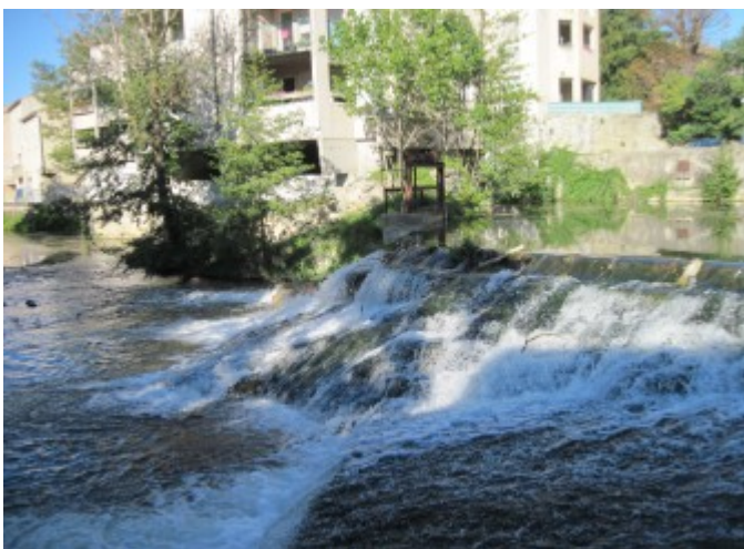
Seuil du Moulin du Roy (Photo BRLi)
