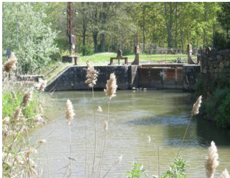
Photo DDTM : système de vannage en rive droite
