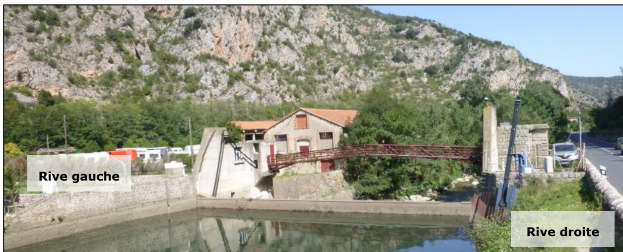
Figure 10 : Accès à la rive droite depuis la nationale N116 (source : Hydrostadium, 2015)
