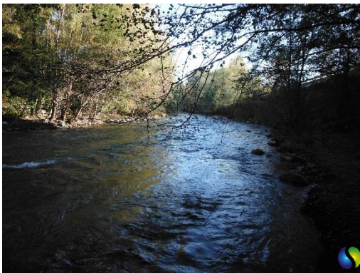
Vue du mur de soutènement de la RN116 en rive droite
