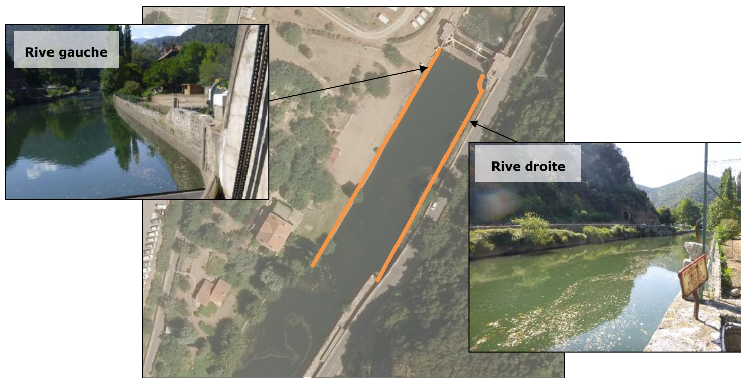
Figure 15 : Implantation de la zone de travaux pour les réparations vis-à-vis des fuites des bajoyers rive droite et rive gauche (en orange) (source : Hydrostadium, 2015)
