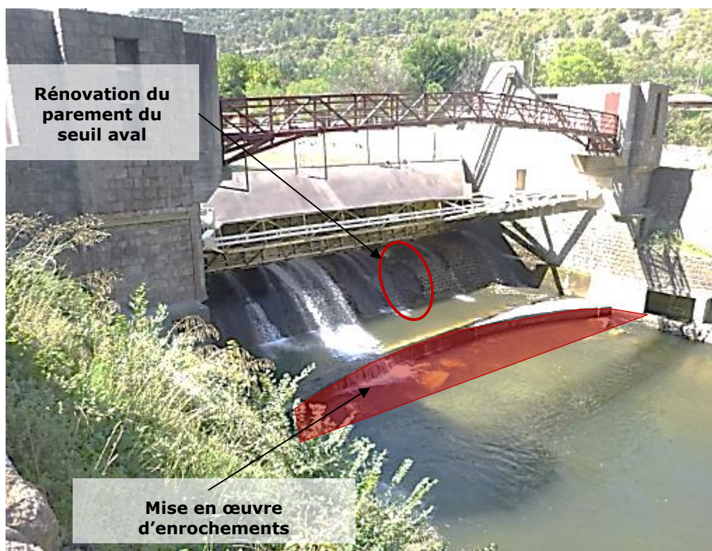
Figure 22 : Implantations des travaux de rénovation du parement du seuil et du radier aval (source : Hydrostadium, 2015)
