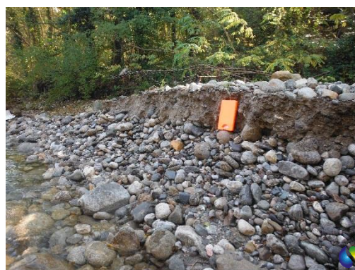
Prise de vue de l'érosion en rive droite
