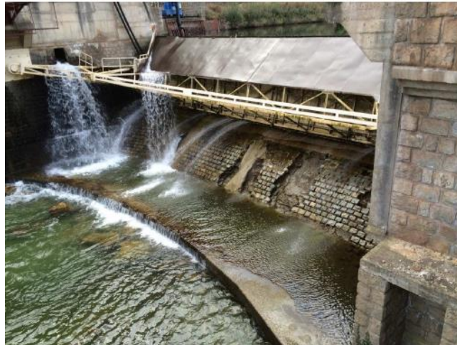
Vue du seuil et du radier en aval du barrage (source : SHR)
