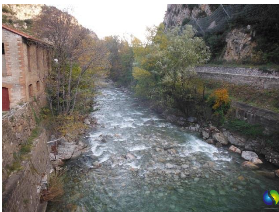
Vue de la Têt en aval du barrage
