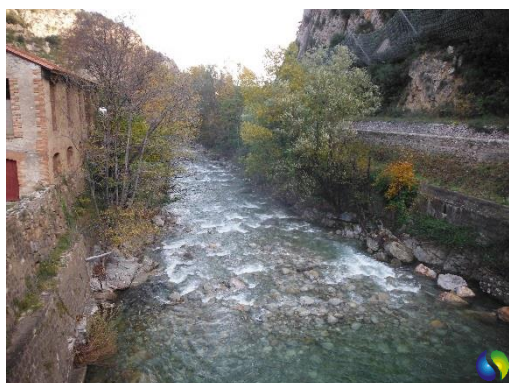
Endiguement des deux rives en début de tronçon
