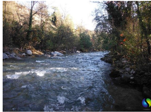
Vue générale en aval des protection de berge – Ripisylve dense en pied de berge
