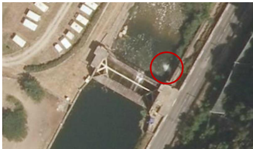
Figure 19 : Implantation du rejet du débit réservé en rive droite du barrage (source : Hydrostadium, 2015)
