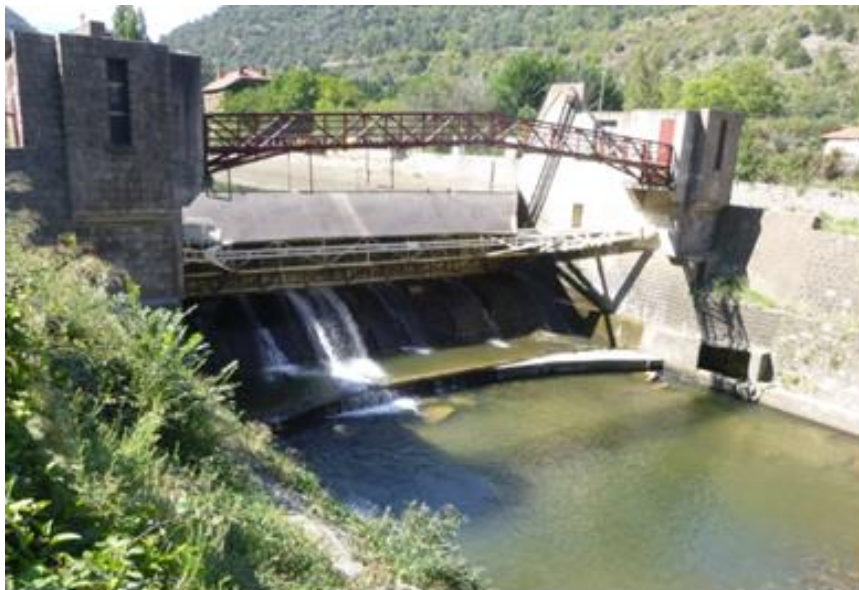
Barrage de Riubanys et sa vanne segment
