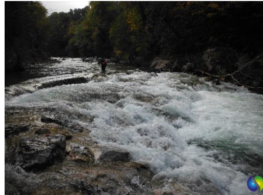
Prise de vue du seuil de la prise d'eau
