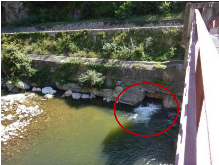
Figure 20 : Rejet du débit réservé en rive droite du barrage (source : Hydrostadium, 2015)
