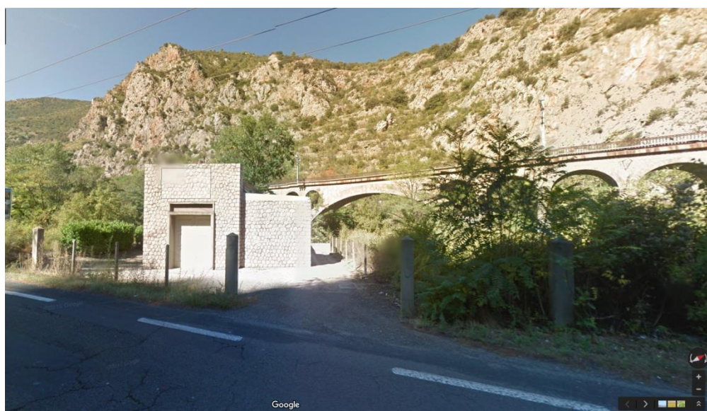
Vue sur la centrale hydroélectrique de Riubanys (source : Google Map)
