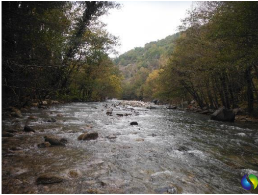
Prise de vue générale du tronçon
