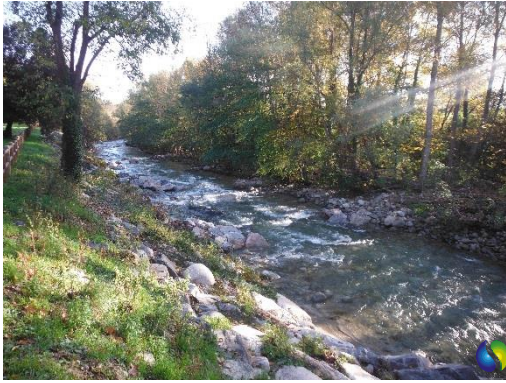
Prise de vue des protections de berges en rive droite et des déflecteurs
