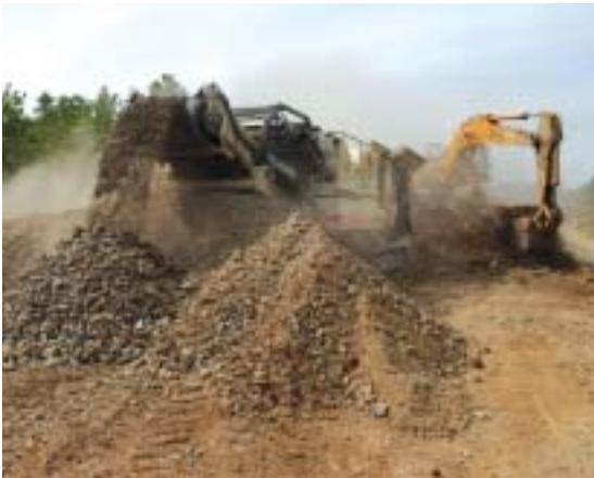
Engins de Travaux Publics - Photo DDE 34
