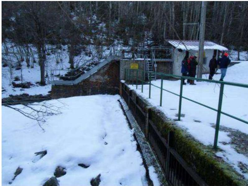
**Figure 18** : *Vue des déversoirs latéraux du canal de fuite*
