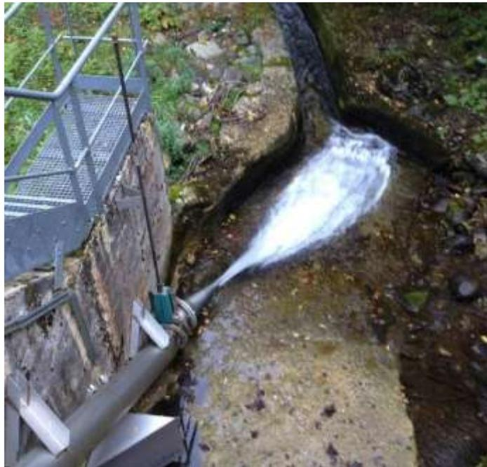
**Figure 20** : Vue aval de la restitution du débit réservé et de la vanne de vidange
