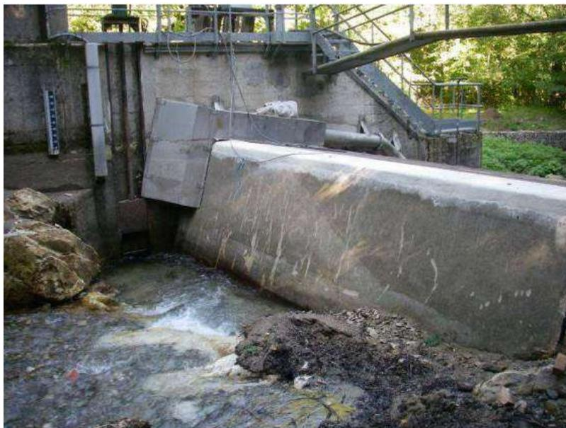
**Figure 19** : *Vue amont de la vanne de vidange et de la restitution du débit réservé*
