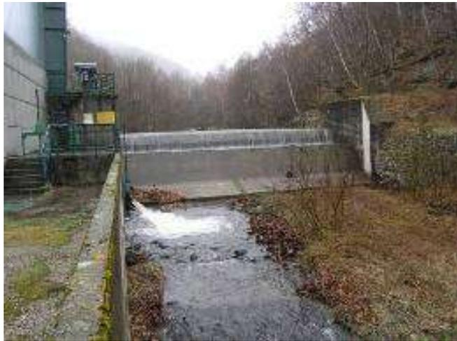
**Figure 4 : Seuil déversant de la prise d'eau**
