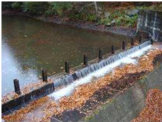
**Figure 5 : Grilles en tôles perforées de la prise d'eau**
