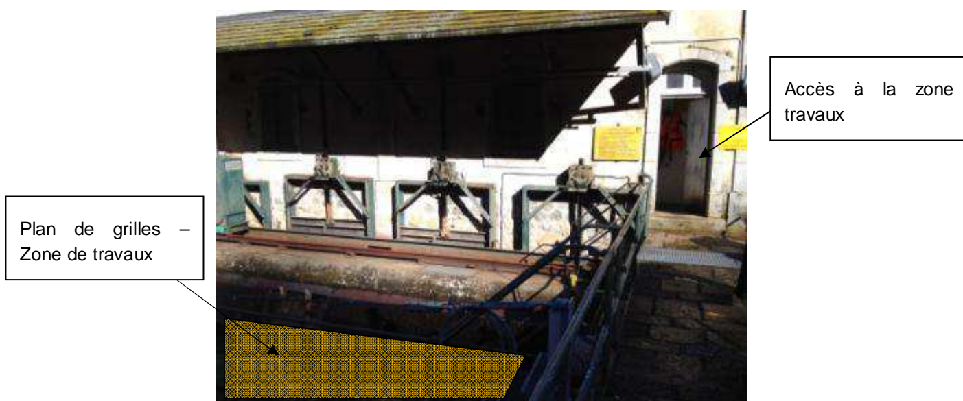
Figure 5 : Plan de grille et accès à la prise d'eau
