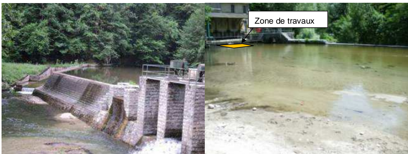
Figure 4 : Vue de la prise d'eau
