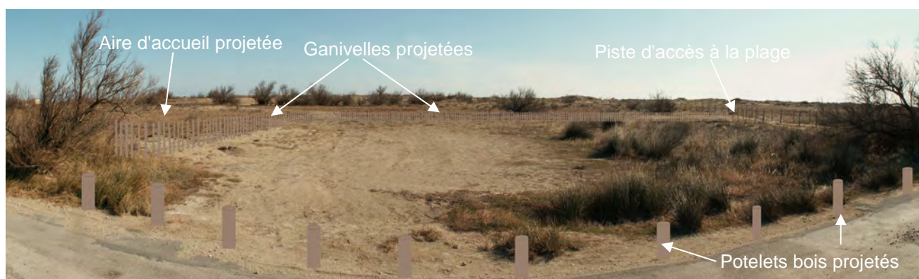
Figure 5 : La zone humide utilisée comme zone de stationnement sauvage sera mise en défens par des ganivelles côté aire d'accueil et par des potelets en bois de 50cm côté route.
