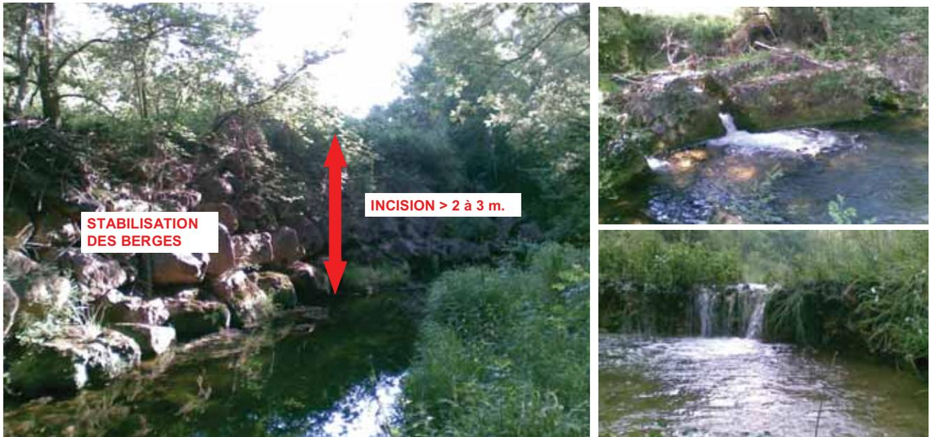
Photos 5 : Situation de l'Aiguillon : à gauche : partie aval = paléoincision avec protection de berge ; en haut à droite : partie médiane = ancien seuil d'irrigation en cours de déstabilisation ; en bas à droite : partie amont = seuil d'érosion régressif au sein du matelas fluvial meuble.
