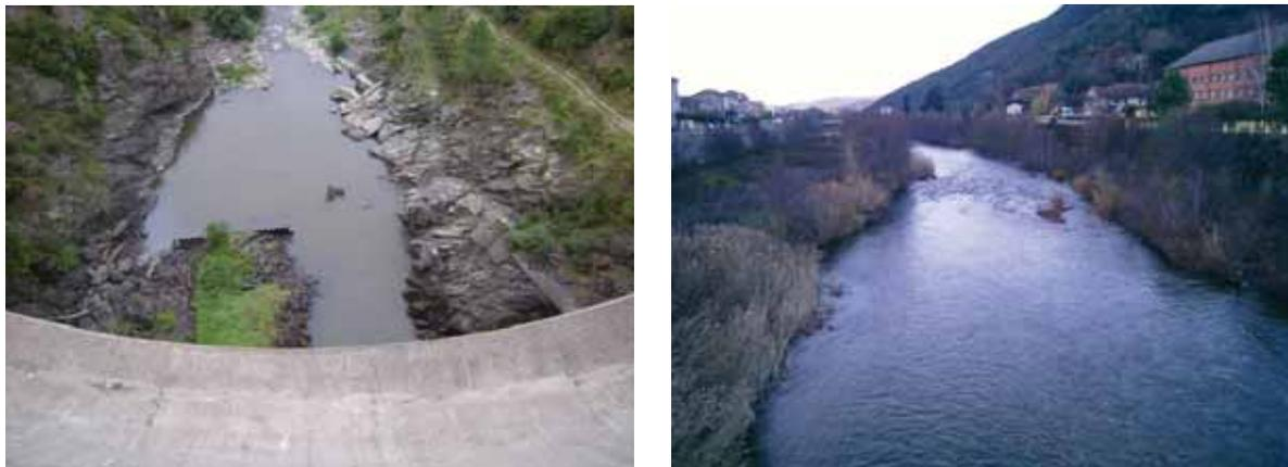
Photos 3 : Déficit en transport solide en aval de la Retenue de Sénéchas et secteur artificialisé de Bessège.
