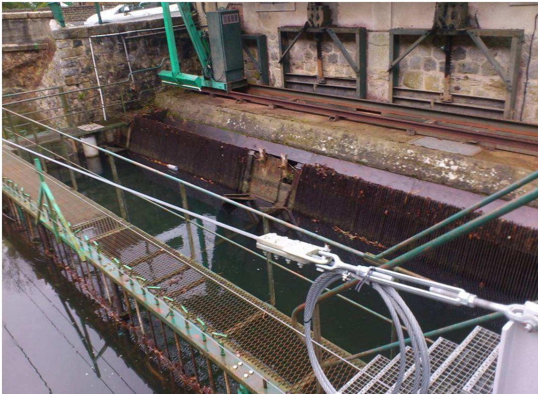
Vue de la prise d'eau côté amont
