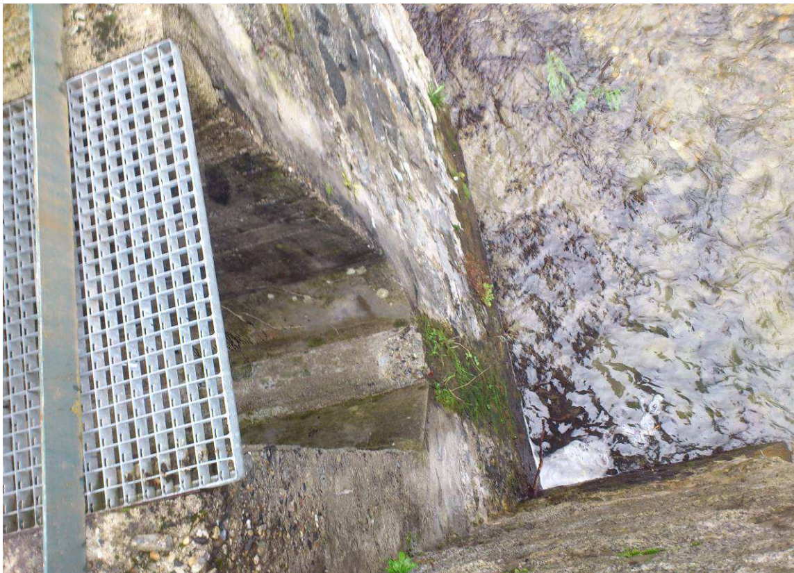
Exutoire de la goulotte de défeuillage à l'aval du barrage
