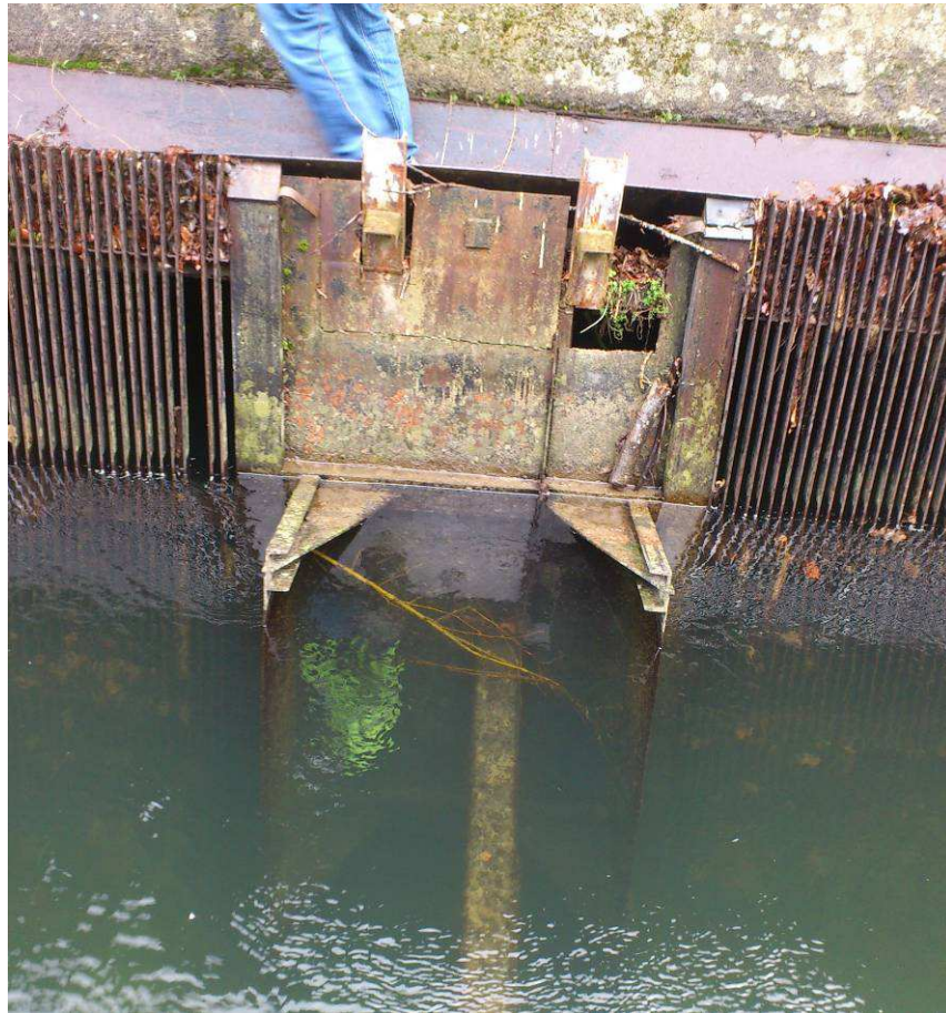
Support de l'ancien dégrilleur positionné au centre de la passe vu côté amont
