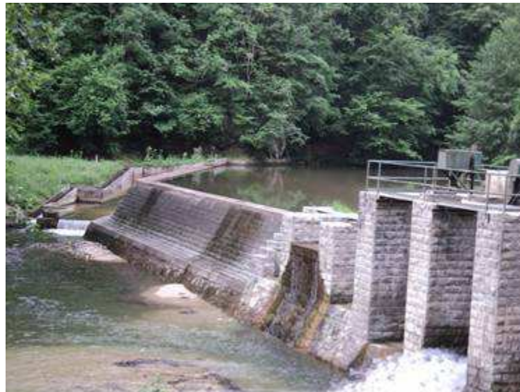
Figure 4 : barrage vu depuis l'aval RG
