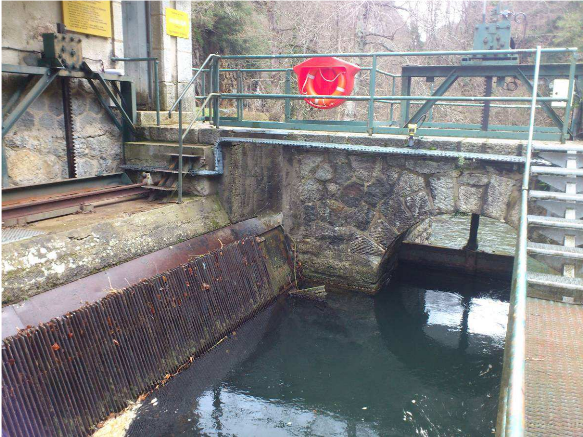
Vue de la prise d'eau depuis la rive gauche
