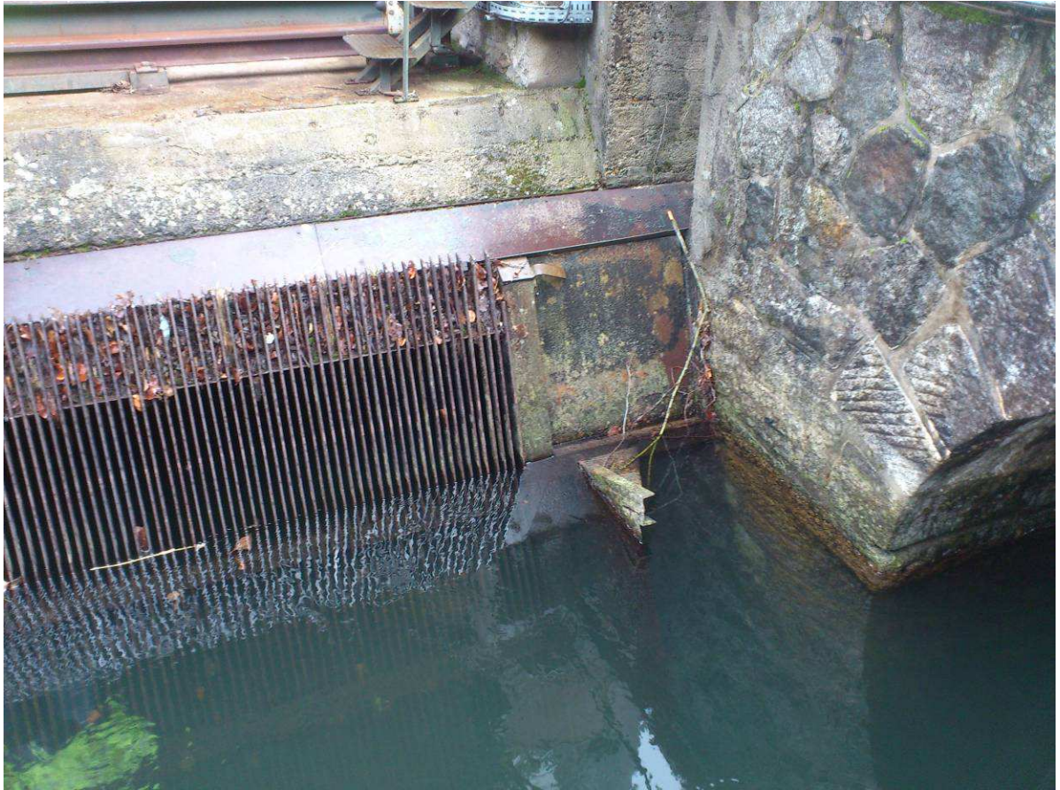
Support de l'ancien dégrilleur positionné en rive droite de la passe vu côté amont
