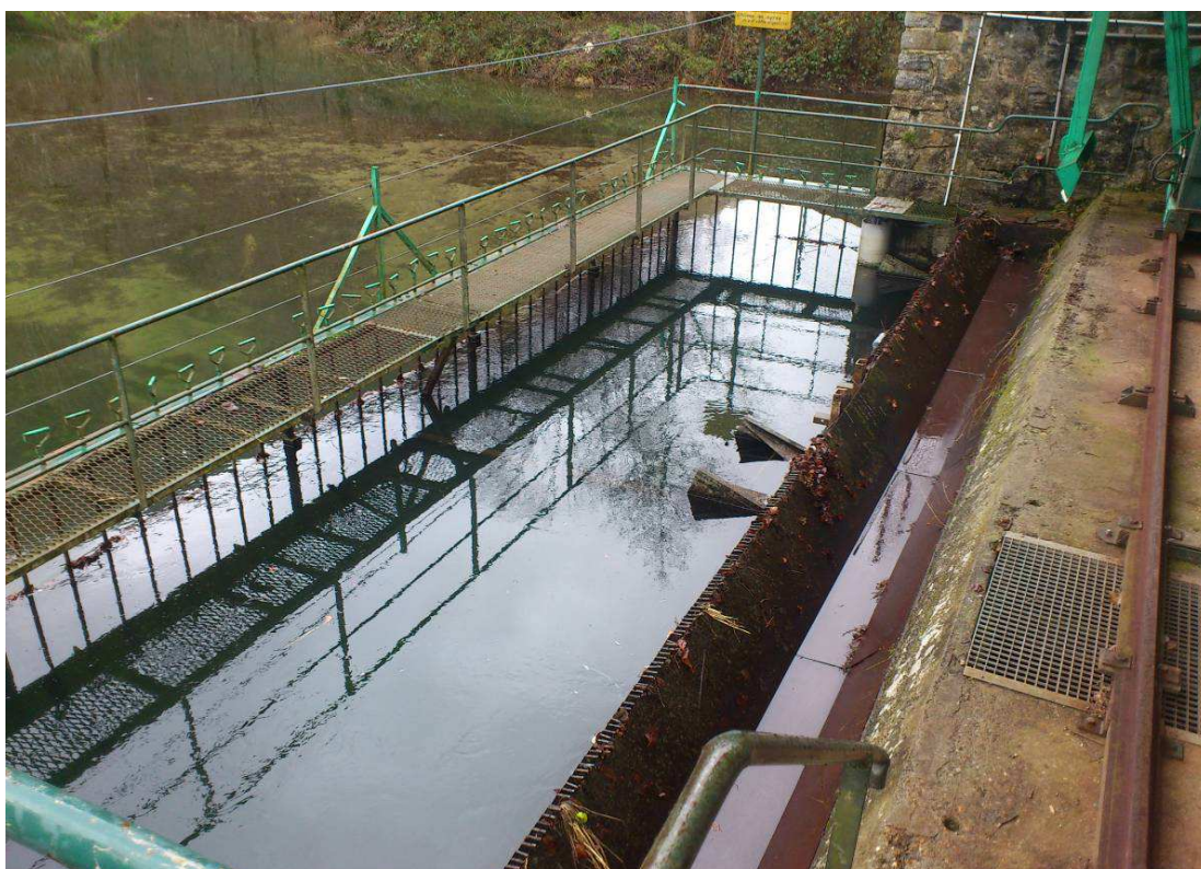
Vue de la prise d'eau côté aval
