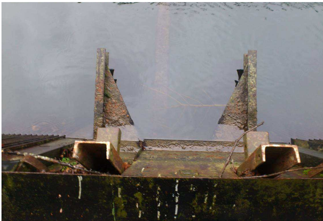
Support de l'ancien dégrilleur positionné au centre de la passe vu côté aval
