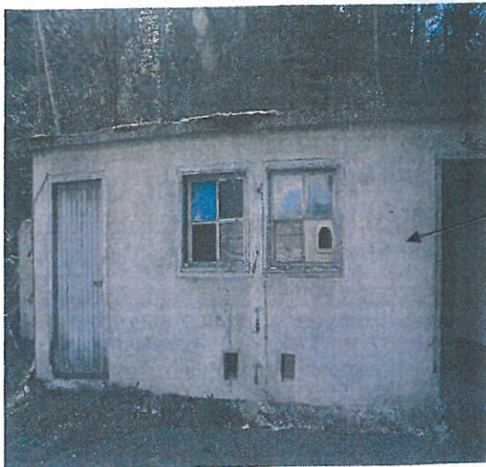
Vues du garage-abri devant être démoli
