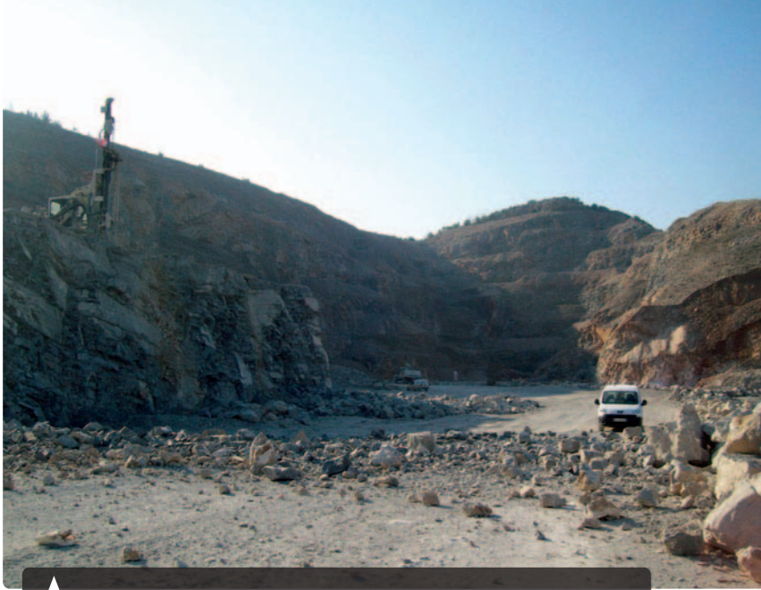
▲ Zones Nord et Nord-est de la zone d'extraction, la foreuse prépare les trous pour le prochain tir de mine.
