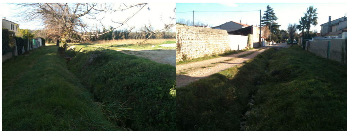
Vue amont du fossé exutoire
