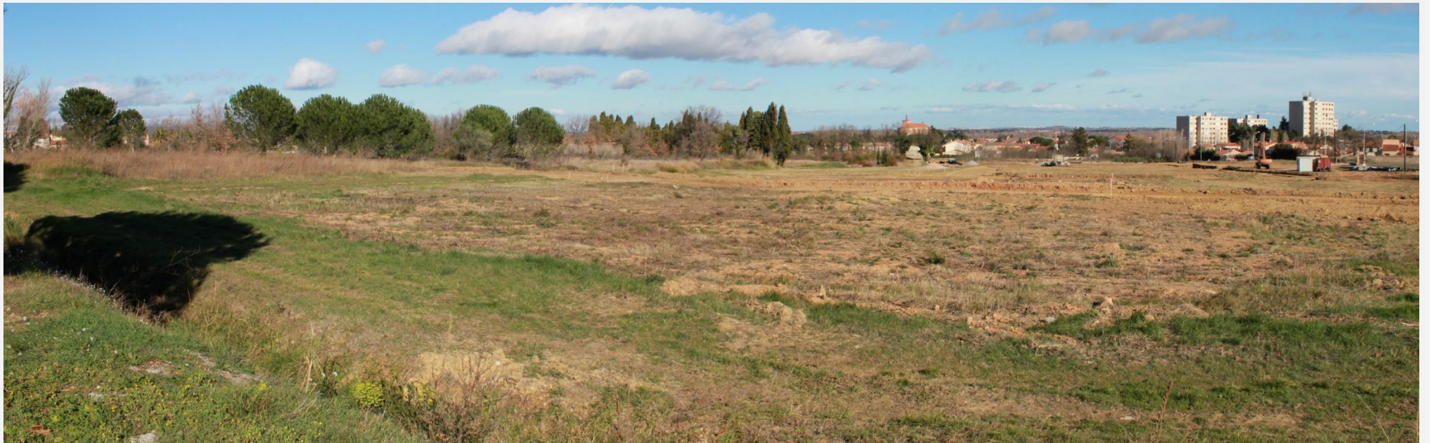
Photographie 1 : Vue générale depuis le Sud, avec à droite le chantier de la tranche 1, en cours de réalisation
