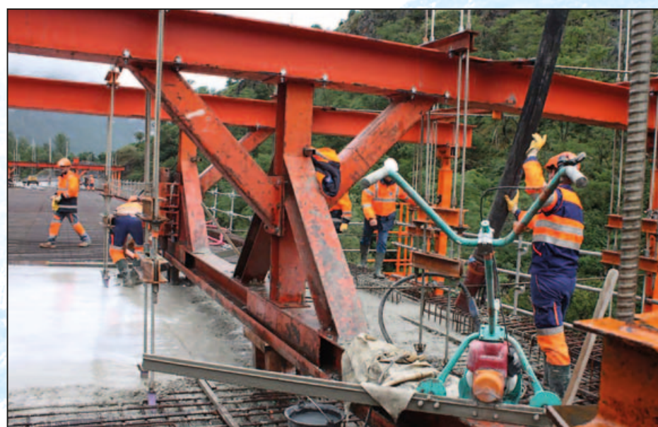
Bétonnage du tablier
