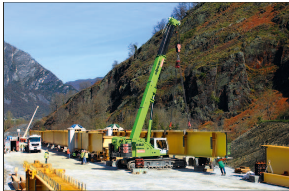
Transport et assemblage de la charpente sur chantier
