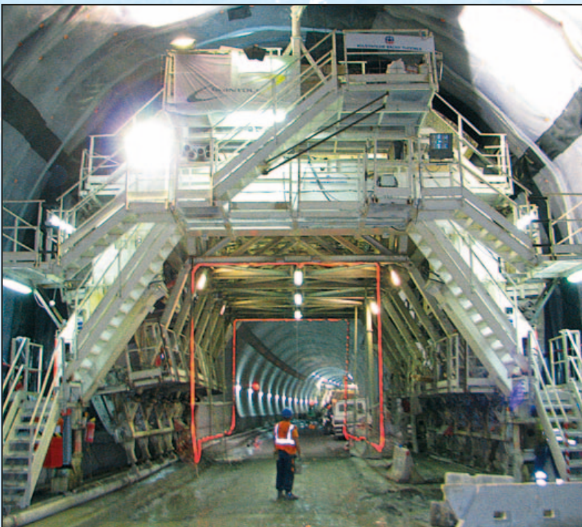
Étanchéité avant bétonnage par l'outil coffrant
