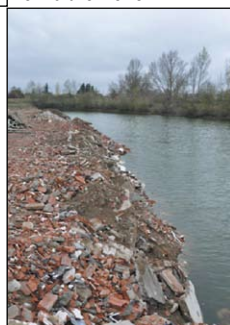
Trou d'eau en cours de remblaiement
