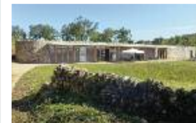
Nouveau bâtiment du belvédère de Blandas
