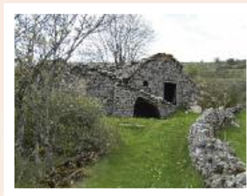
Exemple de bâti inventorié
