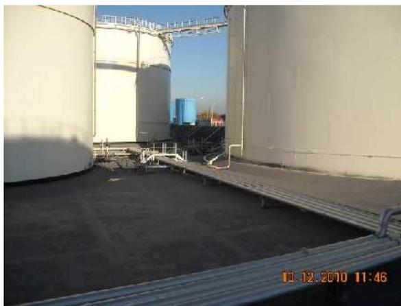
Etanchéité des cuvettes
