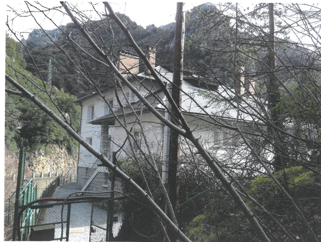
Vue 4 - Vue de la zone d'implantation de la future extension et du talus sur lequel se raccordera la passerelle
