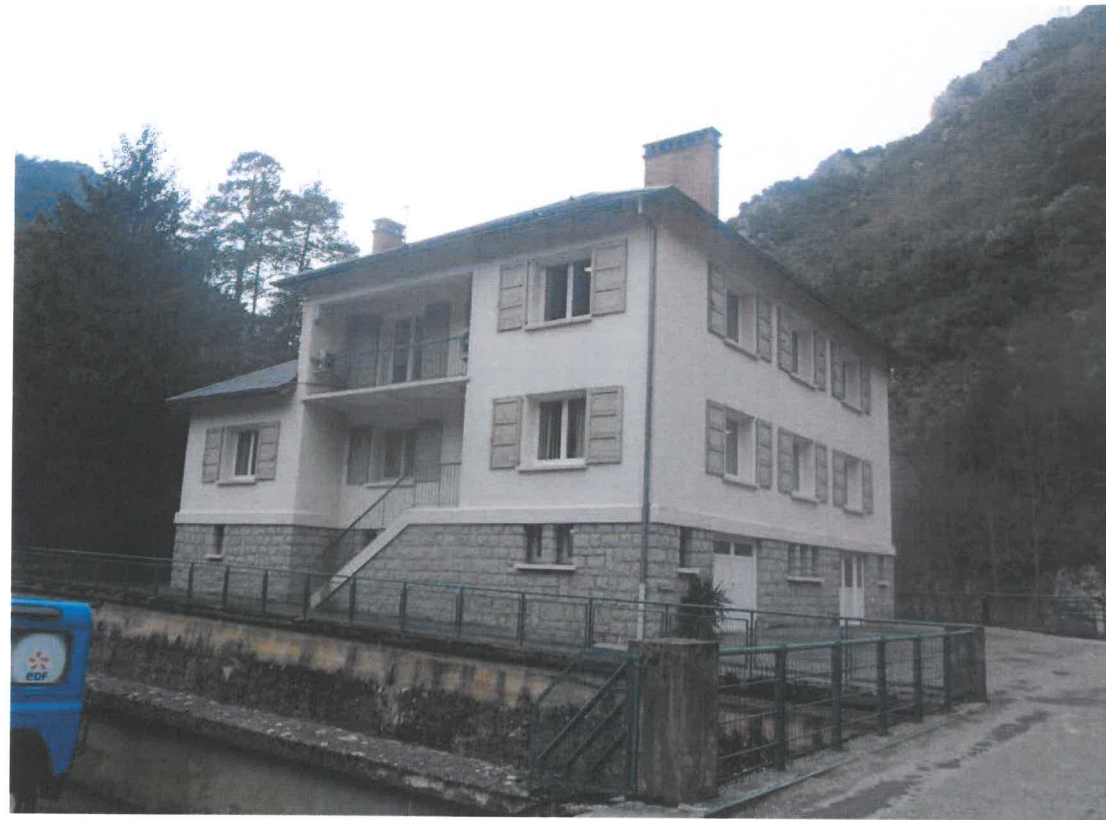
Vue 1 - Vue du bâtiment existant depuis la berge opposée
