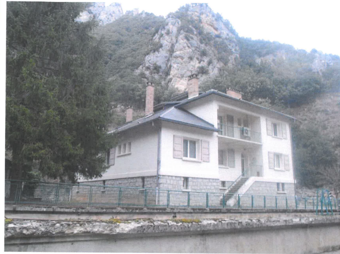
Vue 2 - Vue de la zone d'implantation de la future extension
