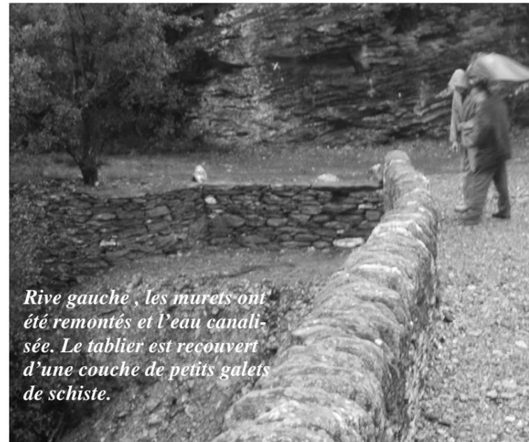
*Rive gauche, les murets ont été remontés et l'eau canalisée. Le tablier est recouvert d'une couche de petits galets de schiste.*
