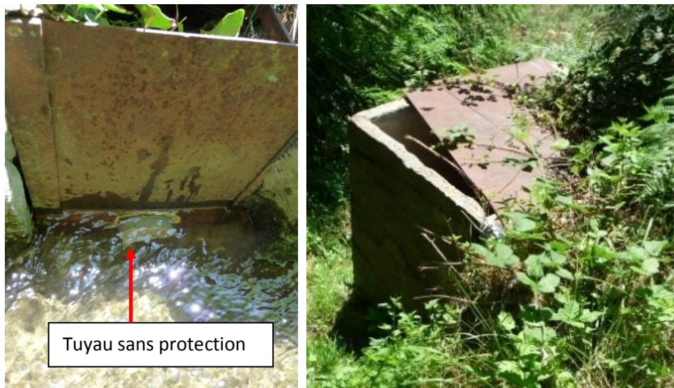
Figure 48 : Captage au niveau d'une martelière amenant l'eau dans une cuve. partiellement fermée.
