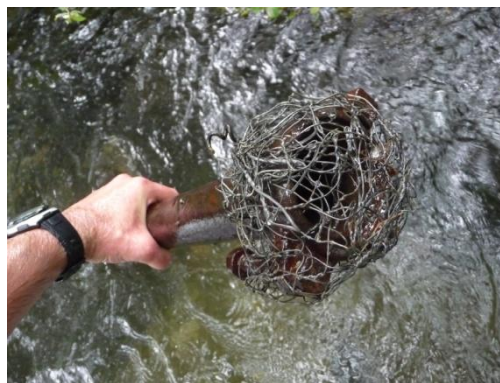
Figure 16 : Tuyau partiellement protégé par une crépine artisanale.
