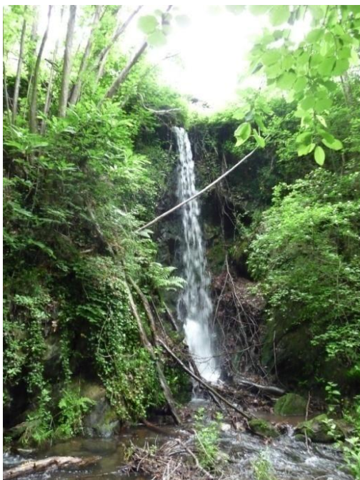
Figure 23 : chute d'environ 10 m au niveau d'un déversoir.
