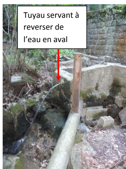
Figure 30 : Tuyau permettant de reverser une petite partie de l'eau du ruisseau
