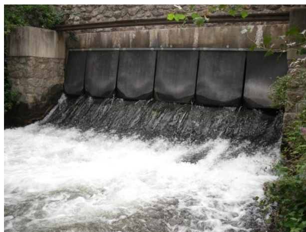
Figure 45 : Canal de fuite de la centrale hydro-électrique d'Olette.
