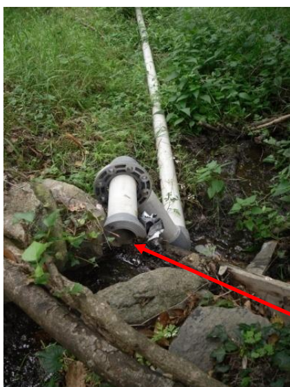
Figure 56 : Canalisation captant l'eau du canal.
