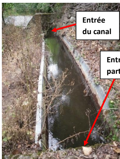
Figure 52 : Entrée du canal avec les rebords en métal.
