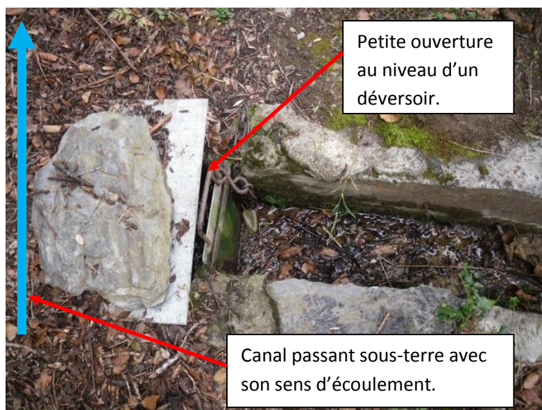
Figure 54 : Déversoir offrant une mince possibilité de sortie à un desman.
