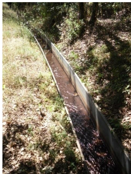
Figure 50 : Rebord du canal en métal.
