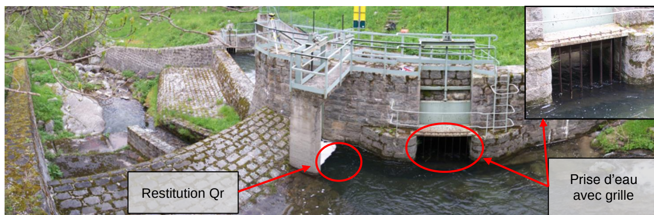
Figure 2 : Seuil vu de l'amont
