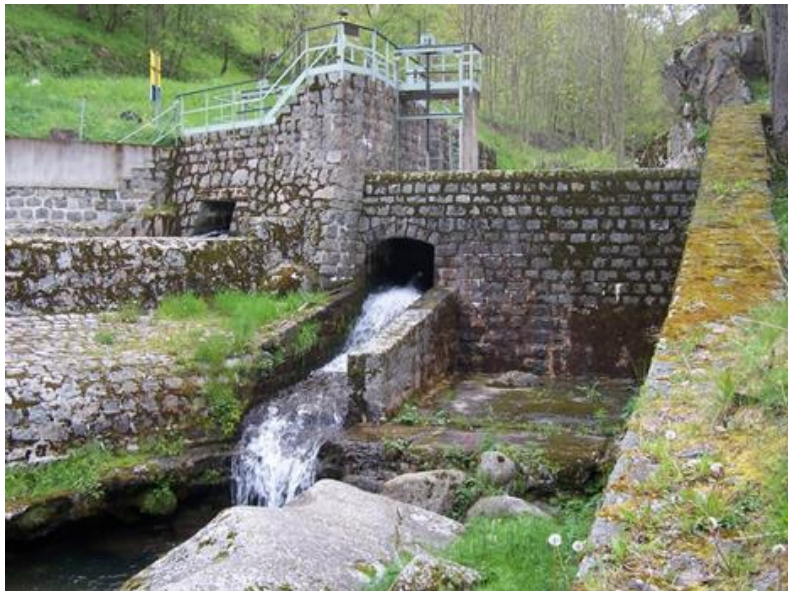
Figure 23 : Restitution du débit réservé
