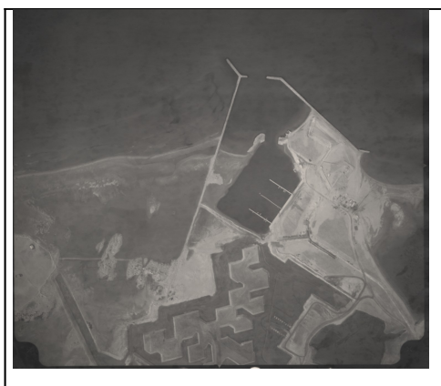
Figure 2. Création de Port Camargue sur la commune du Grau-du-Roi – Photo SMNLR 1972
