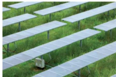
Chaque tracker sera supporté par 3 poteaux métalliques verticaux enfoncés dans le sol. Ils supporteront la table, les systèmes de rotation et les modules. Ces structures auront été préalablement dimensionnées pour résister aux charges de neige et de vent.
