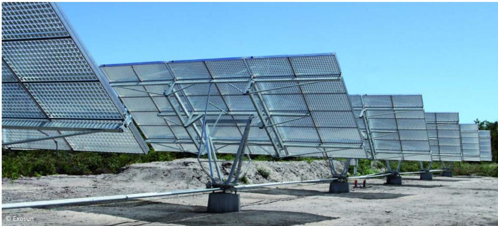
La table supportant les 36 modules mesurera de 7,20 m de long par 3,7 m de haut environ soit 26,64 m<sup>2</sup> par tracker, soit encore 13 700 m<sup>2</sup> pour cette technologie sur l'ensemble du parc.
