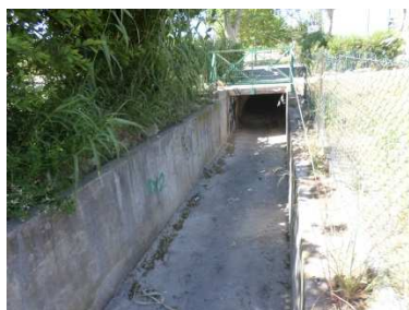
Figure 1 : La Canabière en aval de la traversée de l'avenue de Montpellier
