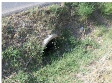
Figure 176 : Buse en  $\varnothing 700$  à moitié remplie de terres et herbes (O33)
