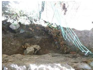
Figure 91 : Fossé de capacité insuffisante
