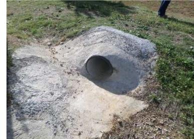
Figure 163 : Débouché de la buse de collecte eaux superficielles
