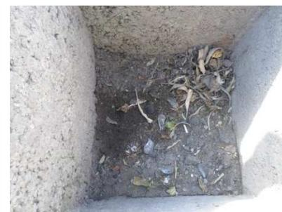
Figure 118 : Evacuation complètement bouchée
