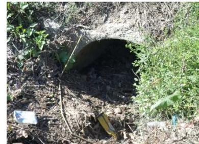
Figure 99 : Débouché de la 2<sup>ème</sup> buse dans le fossé enherbé (partiellement bouchée)
