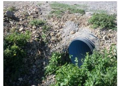
Figure 102 : Buse sous dimensionnée – les eaux pluviales sont passées par-dessus
