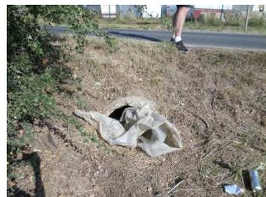
Figure 177 : Débouché de la buse en  $\varnothing 700$ , partiellement obstruée (O33)
