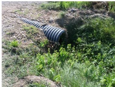
Figure 101 : Buse sous dimensionnée – les eaux pluviales sont passées par-dessus
