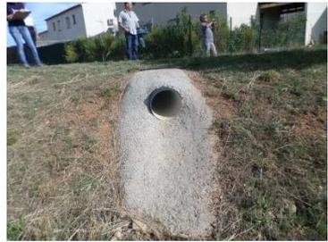
Figure 164 : Débouché de la buse de collecte eaux superficielles
