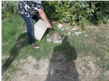
Figure 146 : Trappe de visite - départ du drain débouchant dans le fossé enherbé au Sud (ouvrage O55)
