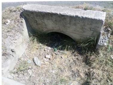
Figure 98 : Ouvrage O42 (partiellement bouché)
