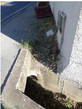
Figure 173 : Débouché de la buse en  $\varnothing 900$  collectant les eaux du rond-point des 4 chemins (O51)
