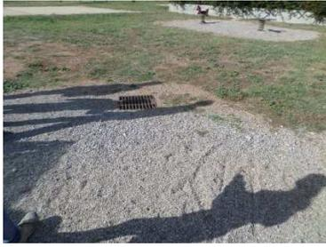
Figure 161 : Réseau pluvial orientant les eaux vers le bassin de rétention
