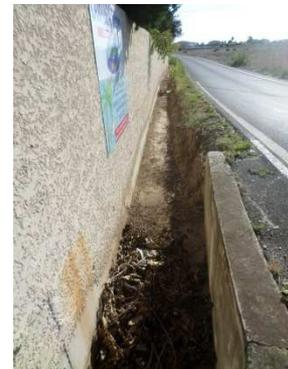
Figure 175 : Fossé bétonné puis fossé enherbé de capacité insuffisante
