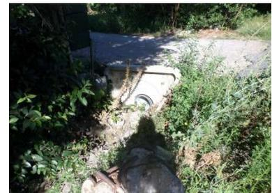
Figure 92 : Buse en  $\varnothing 300$  insuffisante (ouvrage 46)
