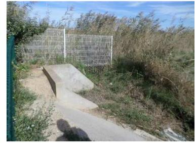
Figure 148 : Ouvrage O55 - Débouché du drain dans le fossé enherbé longeant à résidence au Sud
