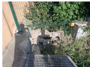
Figure 133 : Ouvrage O40 – débouché des conduites dans un fossé enherbé – clôture faisant office de « dégrilleur »
