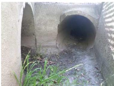
Figure 132 : Ouvrage O40 - débouché des réseaux pluviaux de la rue des Cresses et de la résidence Les Cabrols
