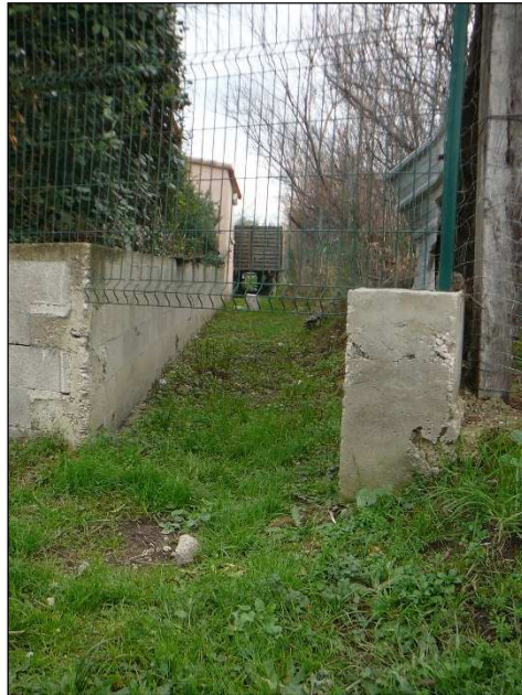
Photo n°1 : Fossé canalisé entre les points « A » et « B »
