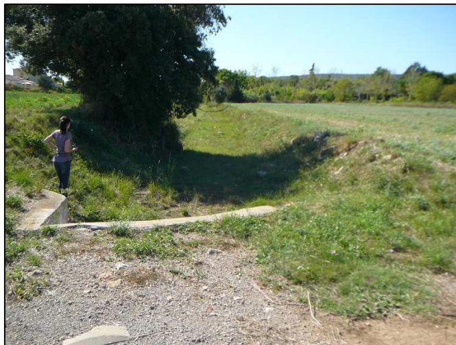
La photographie ci-dessus présentée montre le fossé de Font-Sorbière à l'amont immédiat du chemin de Recouly. Cette configuration est celle que devraient revêtir, avec une largeur adaptée, les « ruisseaux » qui proviennent du bassin-versant rural, tels la Courren, la Canabière ou le Devès...
