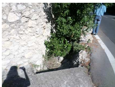
Figure 30 : Débouché du cadre (ouvrage O45)
