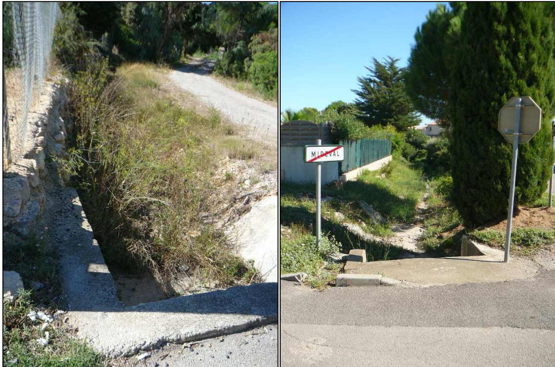
Le ruisseau de Font Sorbière à l'amont et à l'aval du chemin de Font Sorbière : Que se passe-t-il si survient du bassin-versant rural 6,7 m 3 /s ?
