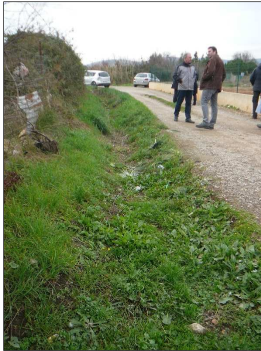
Photo n°3 : Fossé longeant le chemin du Marais à l'aval du point « A ».
