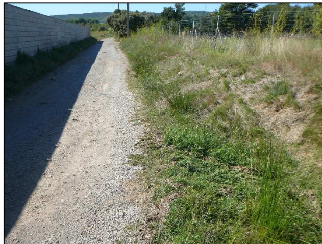
Photographie du fossé entre le chemin de Recouly et le chemin de la Gardelle...
