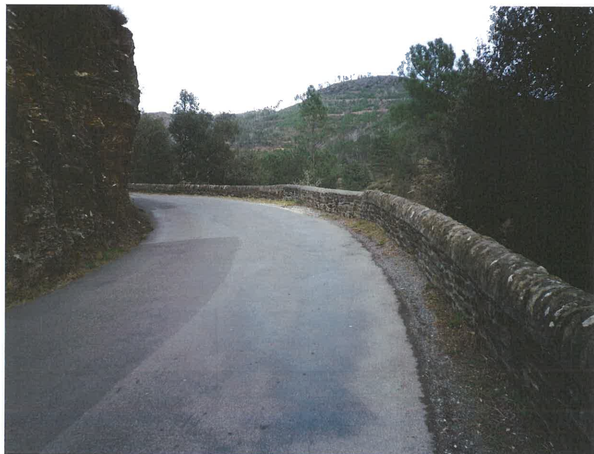
Photographie au niveau du profil 59 (en regardant vers le 57)
