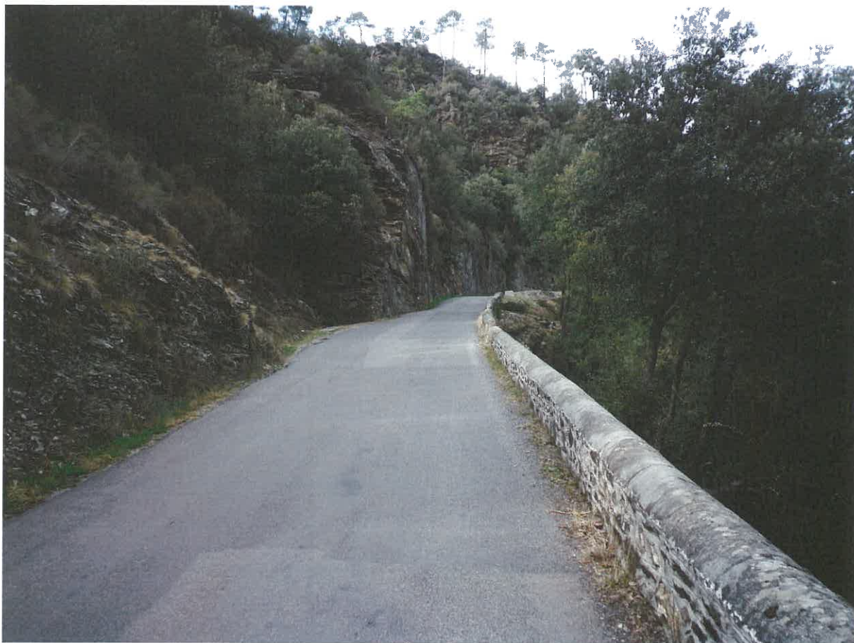
Photographie au niveau du profil 54 (en regardant vers le 50)
