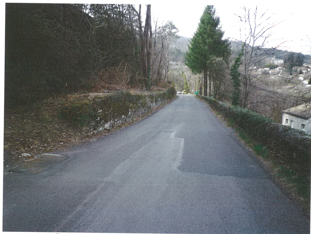
Photographie au niveau du profil 27 (en regardant vers le 6)
