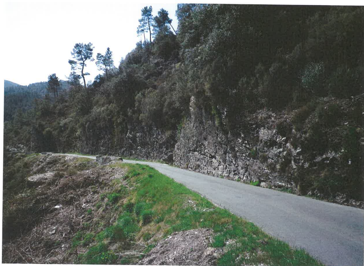
Photographie au niveau du profil 38 (en regardant vers le 40)
