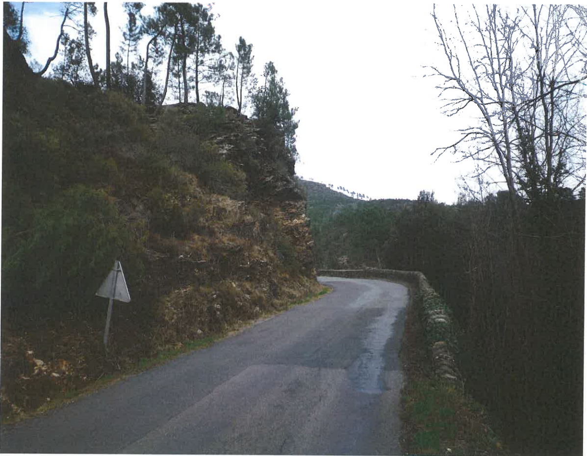
Photographie au niveau du profil 63 (en regardant vers le 60)
