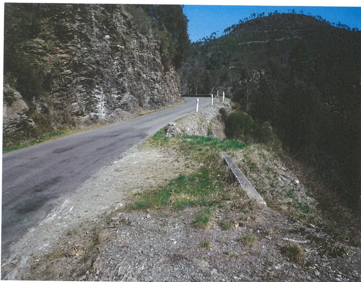
Photographie au niveau du profil 38 (en regardant vers le 30)
