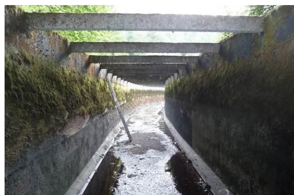
Figures 2 et 3 : Photos de l'ouvrage
