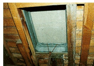
Tabatière dont la vitre a été remplacée par un carreau d'éternit pour atténuer la lumière du jour dans les combles de l'église de Durbuy, Province de Luxembourg. (© J. Fairon, CRC-I.R.Sc.N.B.)
