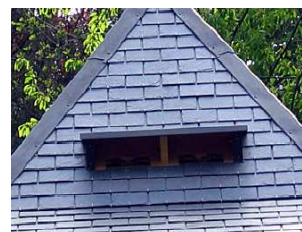
Chiroptière aménagée dans la toiture rénovée d'un pigeonnier, commune de Brassac, dans le Tarn (
