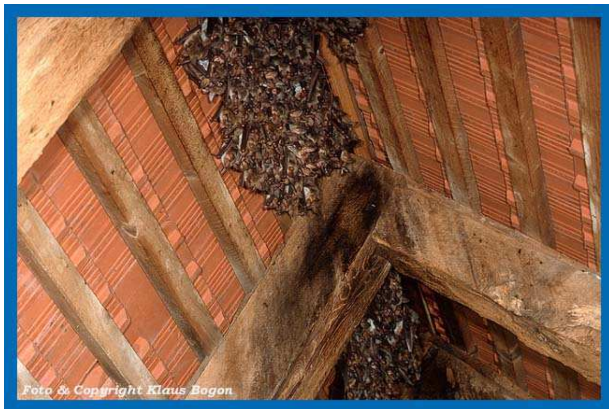
Colonie de Grands Murins dans des combles
