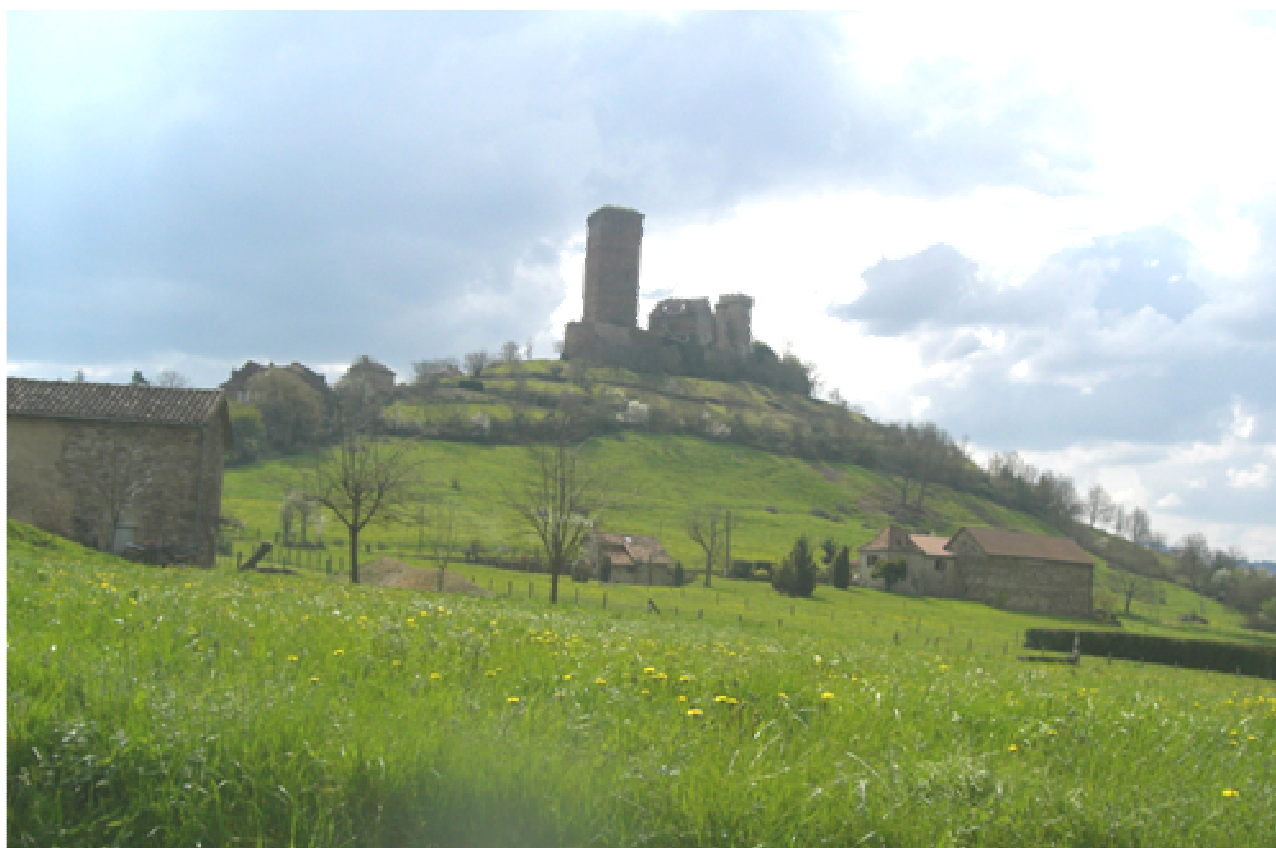
Vue sur la façade Nord-ouest du château.
