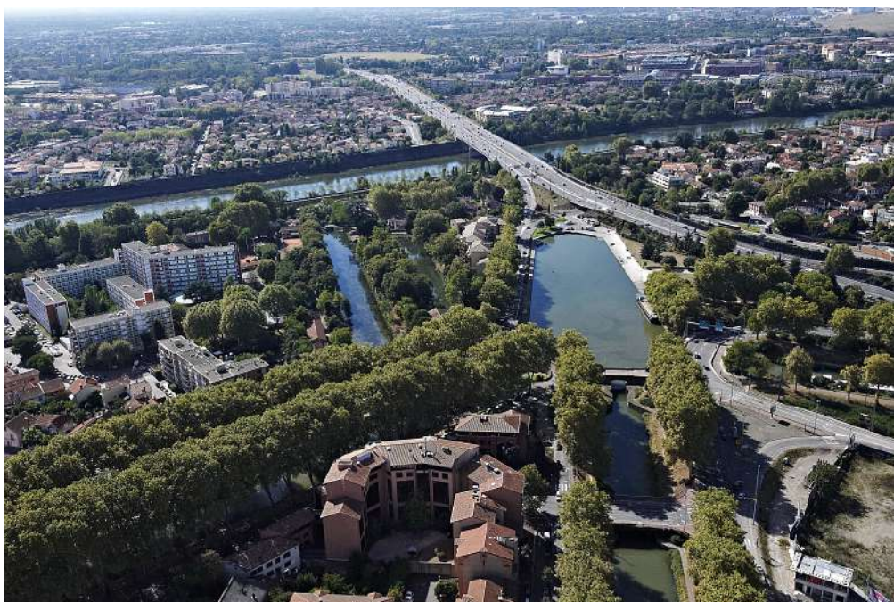
Vue aérienne du bassin de jonction des canaux aux Ponts Jumeaux à Toulouse : canal du Midi, canal de Brienne et canal latéral à la Garonne (source : SMEAG)
