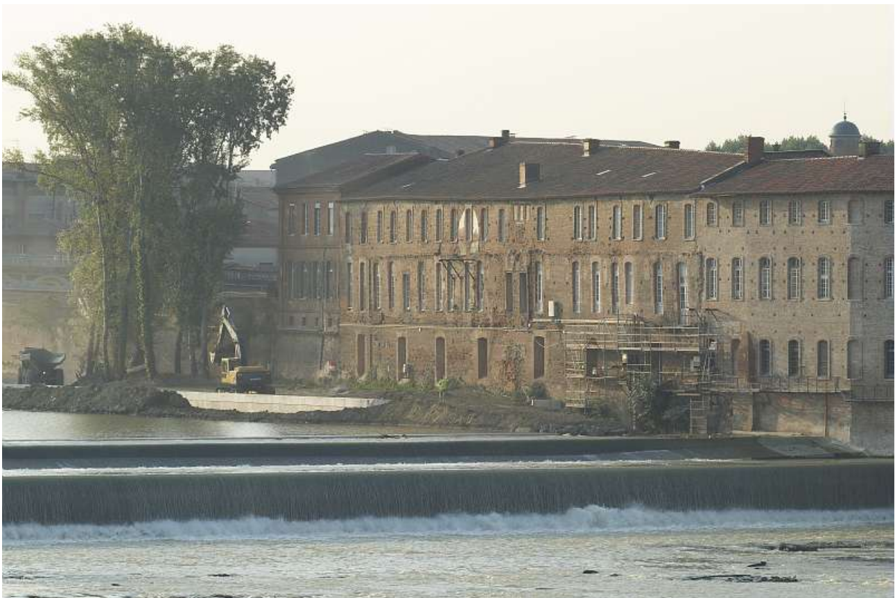
Chantier préparatoire à la mise en place de la passerelle métallique contre la façade de l'Hôpital de la Grave à Toulouse (source SMEAG)
