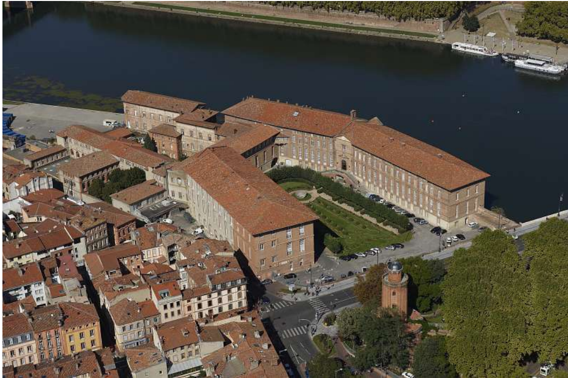
Vue aérienne de l'Hôtel Dieu en rive gauche de la Garonne (source : SMEAG)
