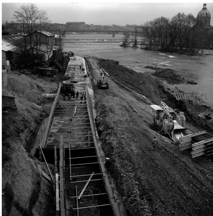
Construction de la digue des Amidonniers – 12 février 1965 (source : AM)
