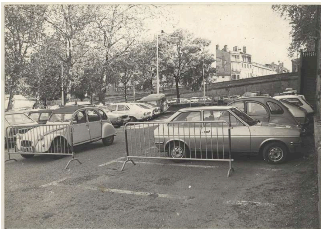
Le Port de la Daurade aménagé en parking – 1972 (source AM)
