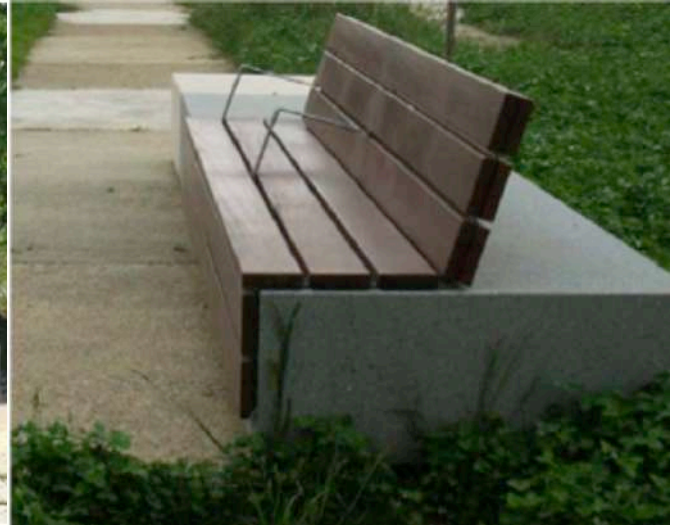
Banc avec dossier en grès et bois adapté PMR type linteau monobloc résistant aux crues
