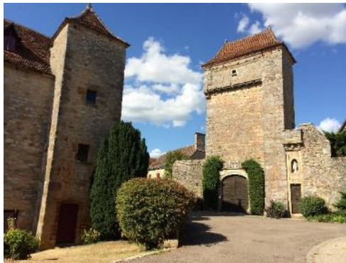
entrée du château
