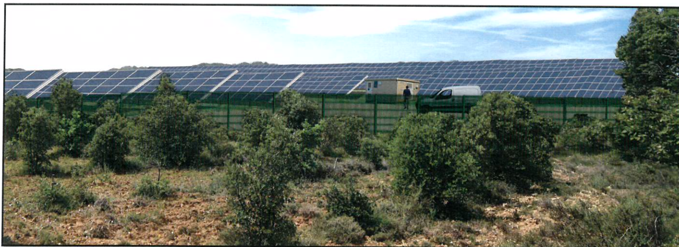
INSERTION PHOTO 1 PC6 - VUE DE PRES
