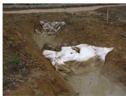
Filtre à cailloux avec géotextile
