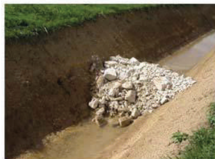
Filtre en cailloux
