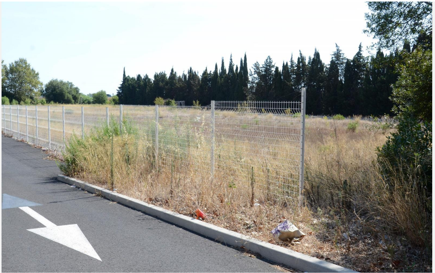
Photographie 3 : Bassin de rétention compensant le parc-relais.
