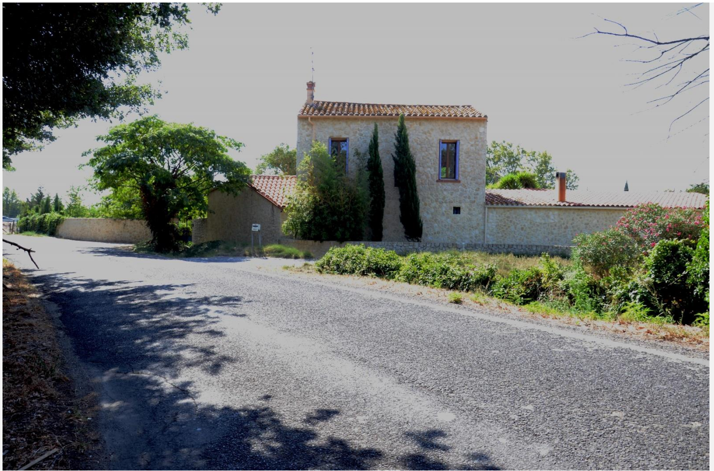
Photographie 9 : Mas dans le secteur central de la zone d'étude.
