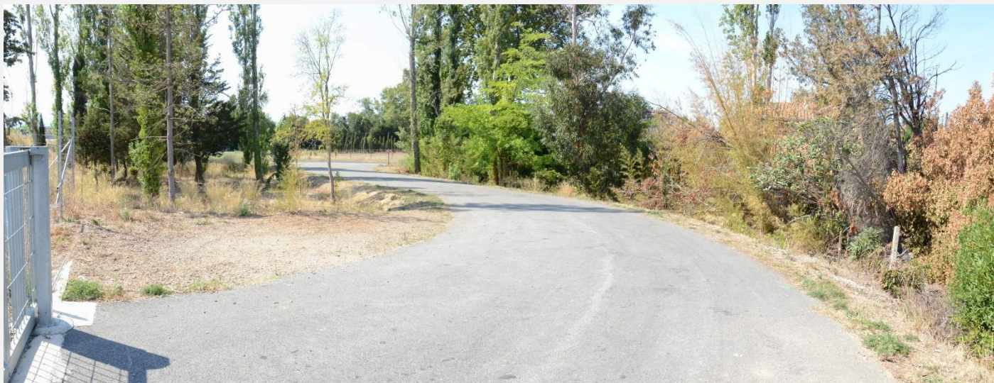
Photographie 11 : Accès de secours à l'autoroute A9 au Sud-Est.
