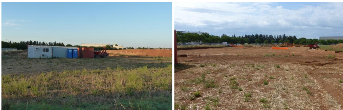
Travaux liés aux fouilles archéologiques au nord-est de la parcelle –CBE, 2017
