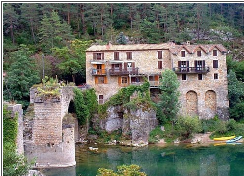
Illustration 5: Ruines du pont de Rozier emporté par la crue de 1900 (source : blog souvenirs caussenards)
