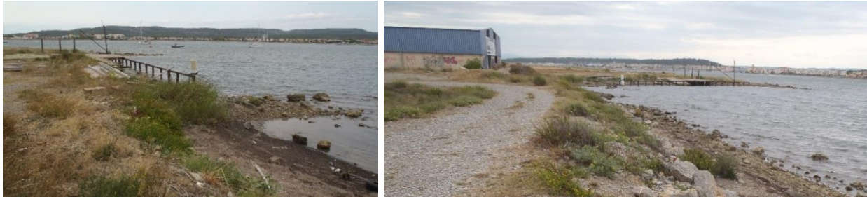
Fig. 21 - Ancienne cale de mise à l'eau – Accès maritime (av.2016)
