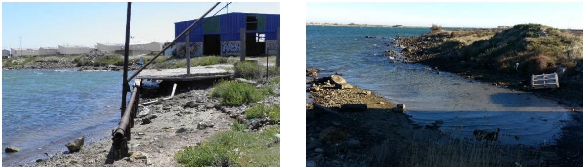
Fig. 22 - Ancienne cale de mise à l'eau – Accès maritime (av.2016)
