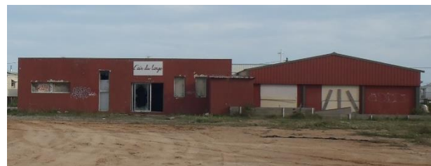
Fig. 19 - Hangar rouge (av.2016)
