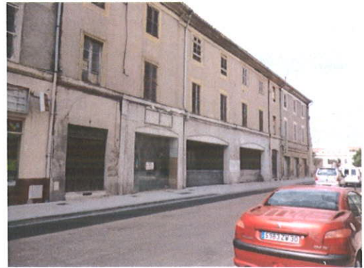
Photo 4 : Immeuble Rue de la République.
