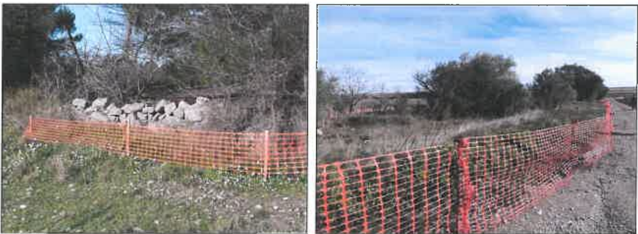
Exemple de mise en défens d'un gîte à reptiles et de secteurs enherbés favorables à leur alimentation, à proximité immédiate d'une emprise d'aménagement
