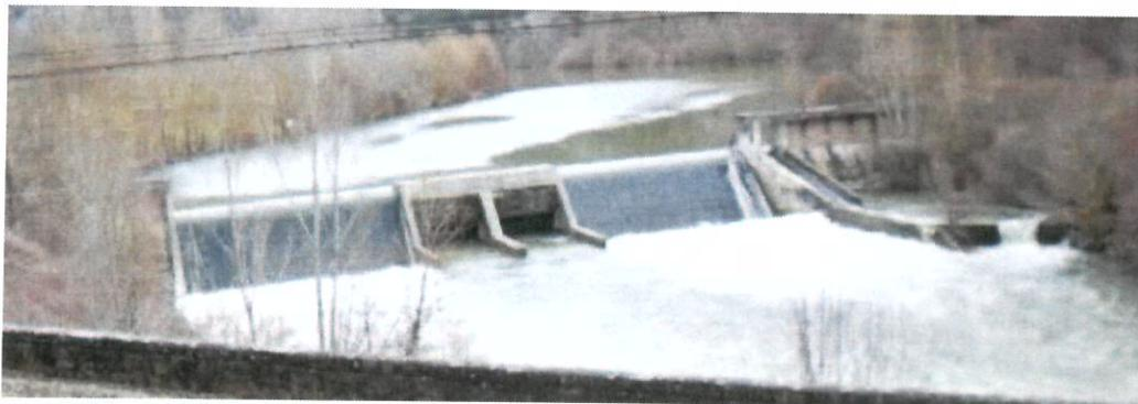
Le projet consiste à équiper le barrage d'une turbine de type VLH\* (Very Low Head) 3550 non relevable en partie centrale pour une puissance maximale brute de 674,9 kW. Le débit d'équipement est fixé à 16 m<sup>3</sup>/s, soit 102 % du module, la hauteur de chute est de 4,30 m. Une vanne de dégravage d'une section de 17,5 m<sup>2</sup> sera mise en place latéralement à la turbine, dans la continuité des 2 pertuis.
