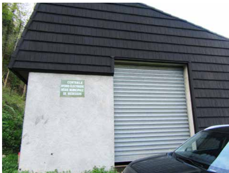
Concession de Goulier - centrale hydro-électrique - photo DREAL Occitanie
