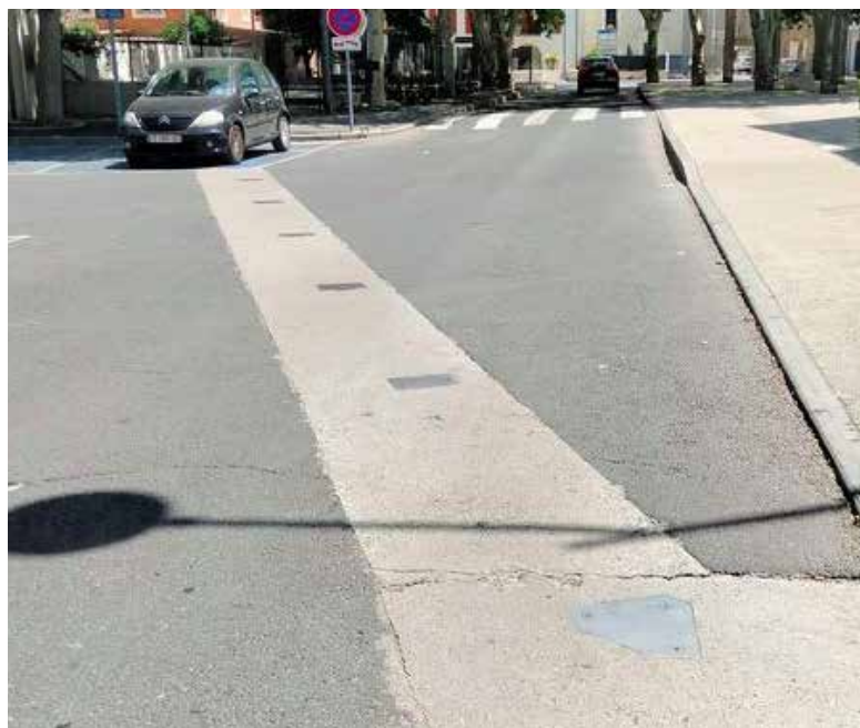
Ancrage de poteaux de batardeaux à Sérignan (Hérault) - photo DREAL Occitanie
