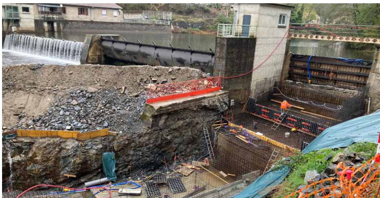
Phase chantier du barrage des Salvages (Hautes-Pyrénées) - photo DREAL Occitanie
