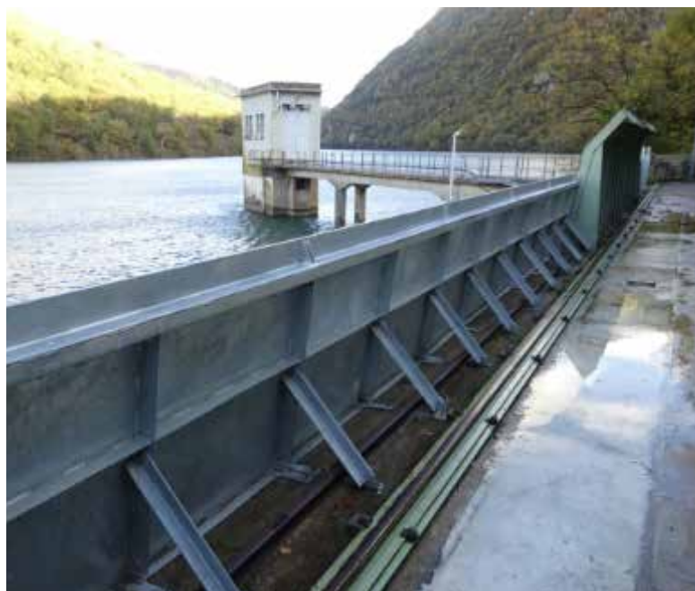
Pare-embâcles en rive gauche amont du barrage de Pinet – photo DREAL Occitanie
