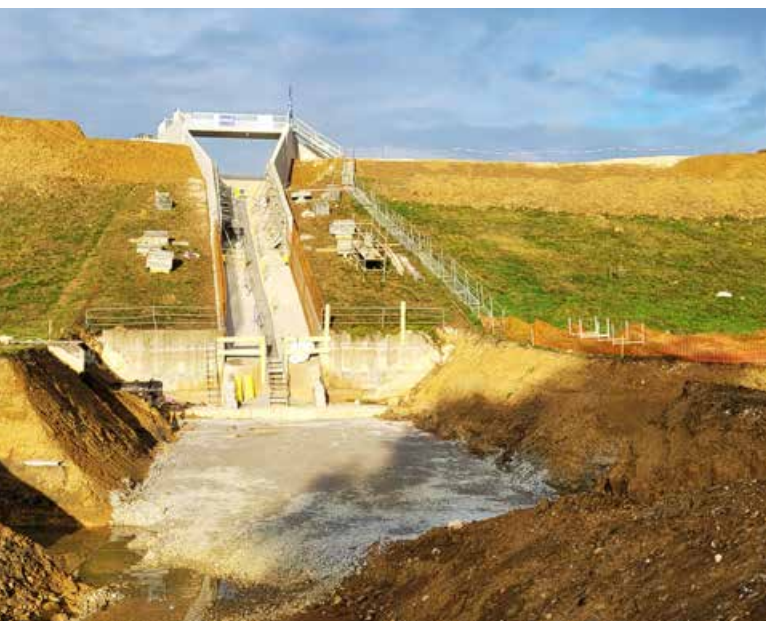
Barrage de Savères (Haute-Garonne) - photo DREAL Occitanie
