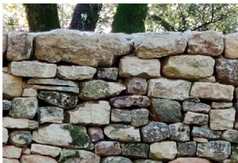
Muret pierres sèches à double parement
