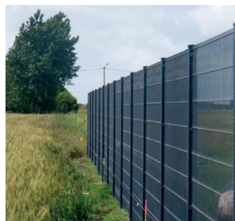
Clôture de bassin en panneaux rigides de treillis soudés
