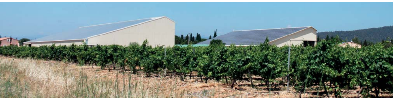
Des hangars photovoltaïques en bordure du canal.
