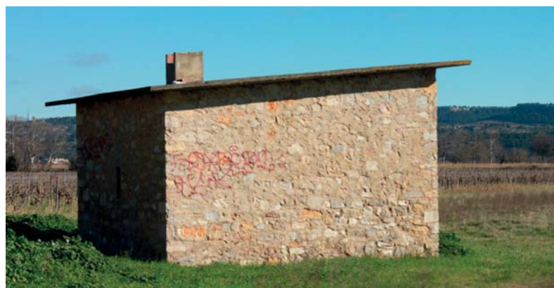
Un mazet dénaturé par sa toiture béton.
