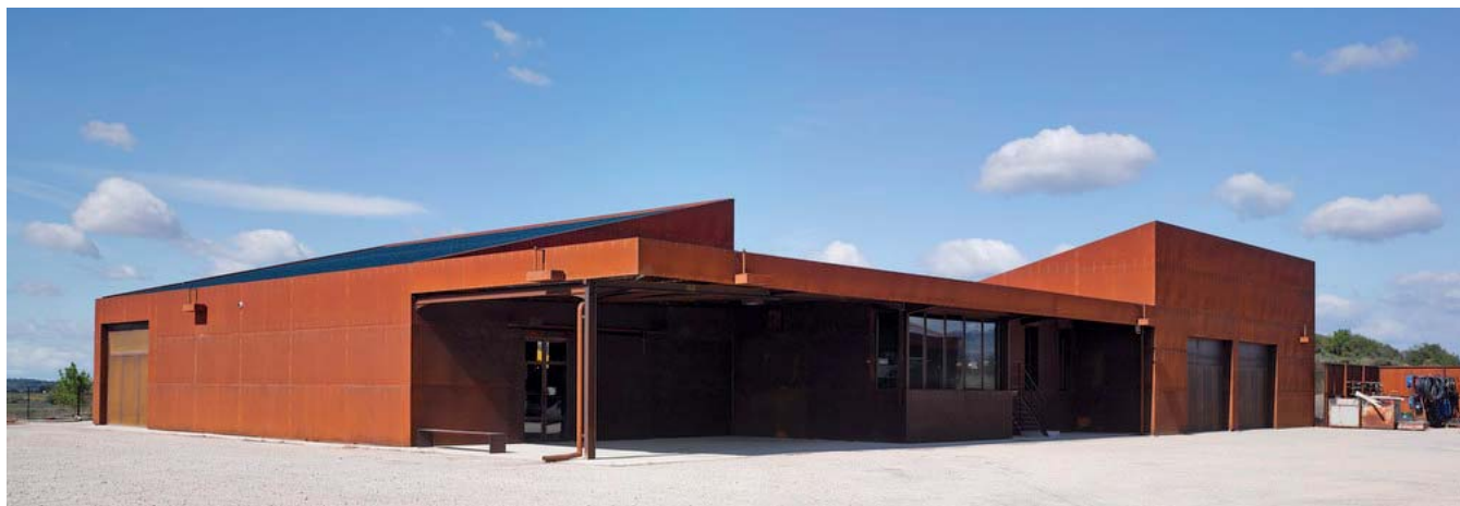
Moulin du Mas Palat / Alain Fraysse Architecte
