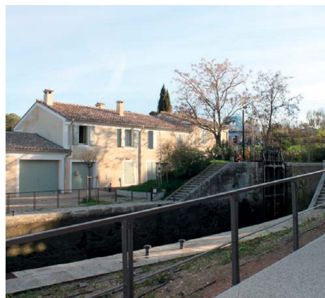
Une des écluses de Fonsérannes
