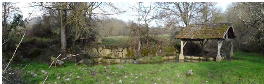
Lavoir de Bouch - Montesquieu Avantès - PNRPA - 2016
