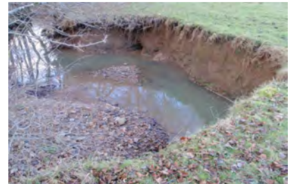
Erosion et présence de ragondins - Sycoserp - 2015
