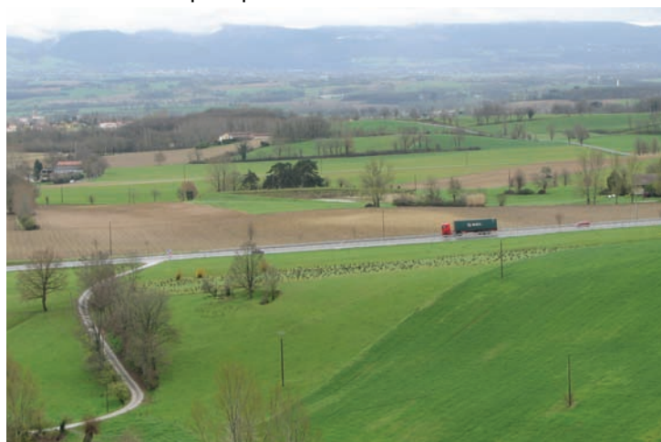
RN 126 au niveau d Saint-Germain-des-Prés (Photo Egis environnement - 2007)
