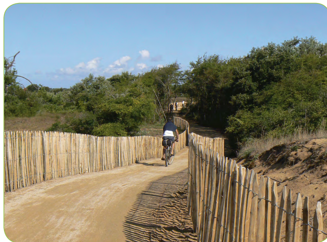
Dunes de la Sauzaie : canalisation et préservation de la dune par ganivelles
