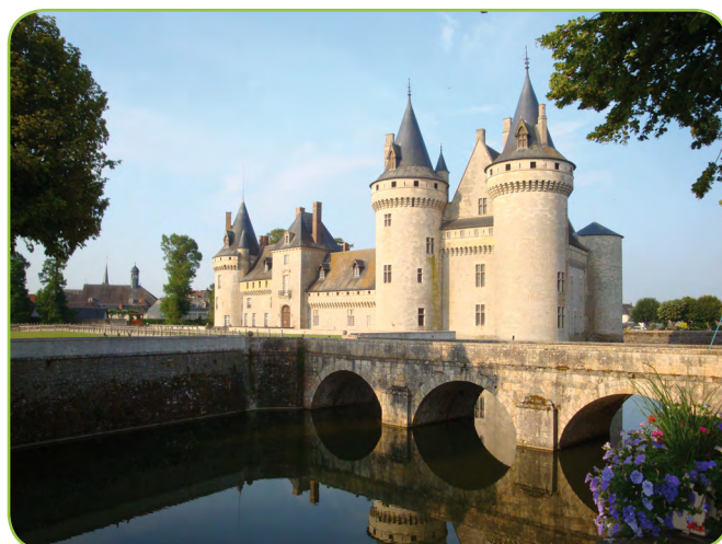
Sully sur Loire, rive sud de la Loire, Loiret
