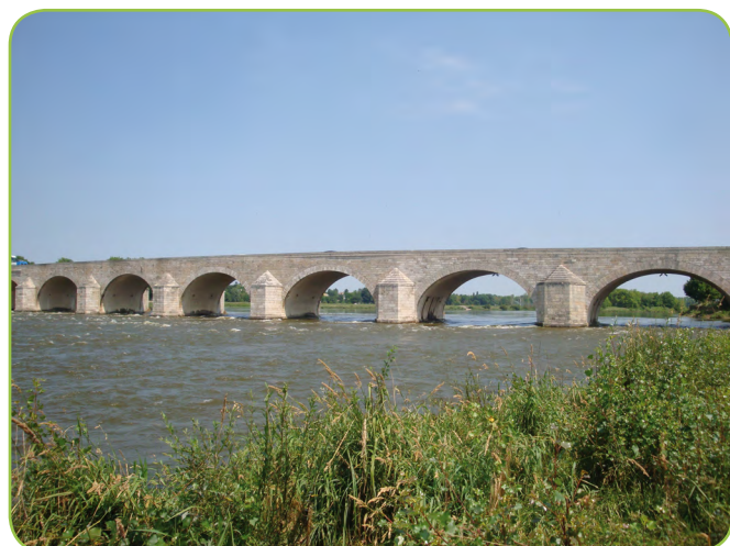
Pont de Beaugency
