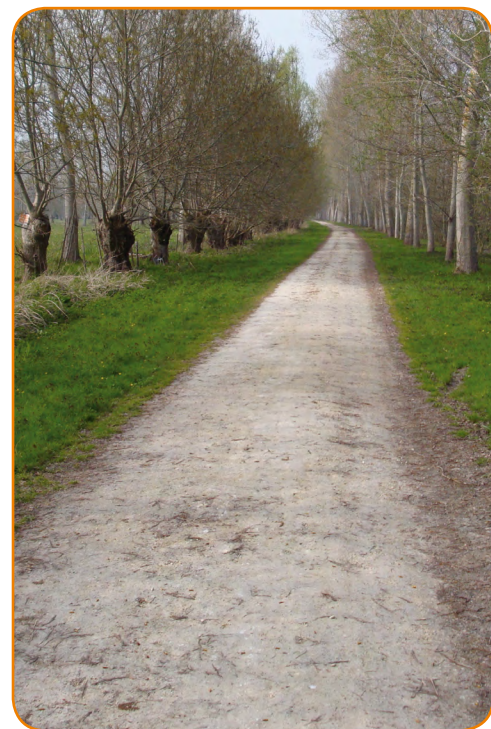
Exemple de chemin existant réhabilité en grave calcaire
