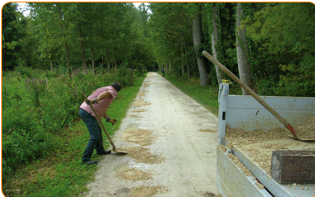
Comblement des nids de poule, réseau cyclable du Marais poitevin
