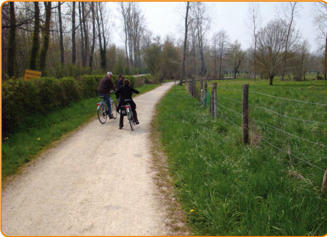
Marais poitevin, aménagement des chemins ruraux traditionnels : grave calcaire compactée, matériau local adapté aux caractéristiques et variations hydriques du sol (site classé, site Natura 2000, secteur régulièrement inondé).
