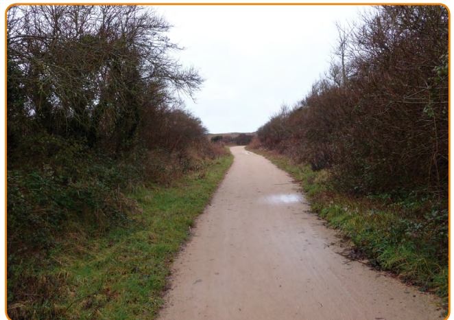
Milieu dunaire en Vendée : revêtement en sable compacté sans liant, qui se révèle résistant dans la durée bien roulant, compact, et à faible entretien ( espace remarquable du littoral, site classé et Natura 2000 ).
