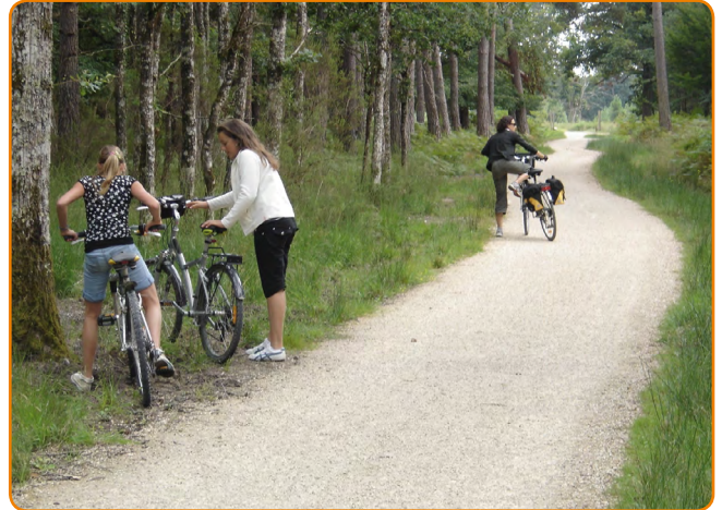
Parc de Chambord : dans et aux abords du parc, intégralement en site classé, choix d'un stabilisé calcaire, sorte de béton calcaire réalisé avec des matériaux d'une carrière proche (Grave des Minières).
