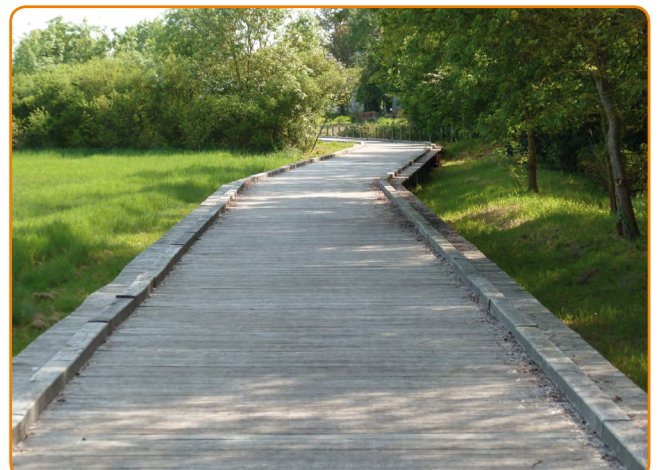
Charente-Maritime : sur une section nouvellement créée le long d'une prairie humide, choix d'un platelage bois (site classé et Natura 2000).
