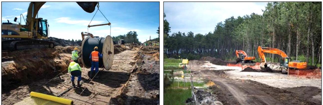
*Remblaiement : A gauche, déroulés du grillage avertisseur et fibre optique de détection au-dessus du petit remblai ; à droite, remblai supérieur avant remise en état définitive.*
