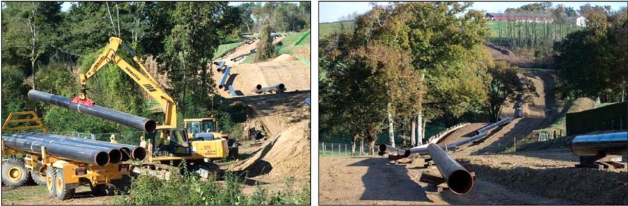
*Acheminement des tubes sur le chantier et bardage sur la piste*
