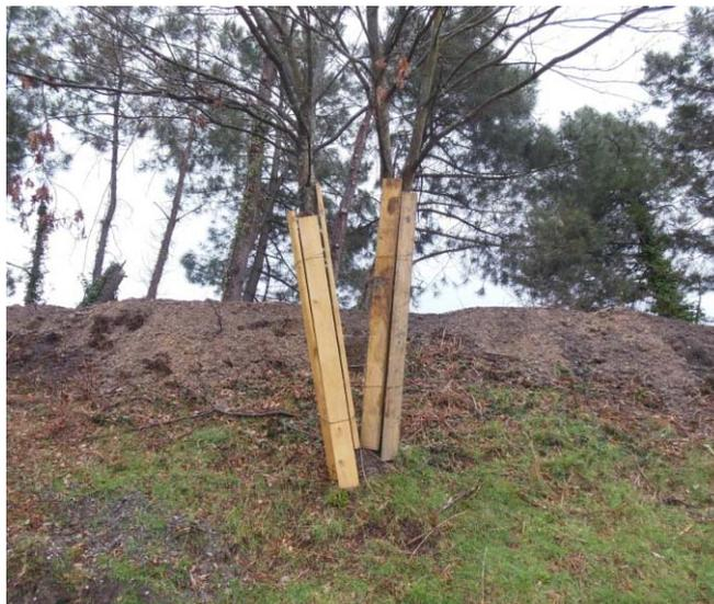
Exemple de protection de futs d'arbres sur chantier - (Photos GERE A)
