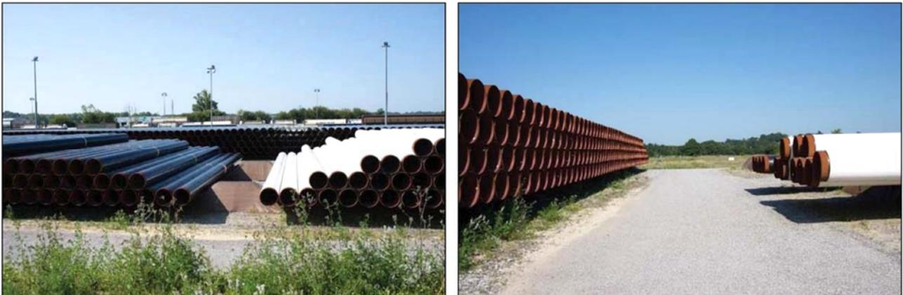
*Parc à tubes avec en noir, les tubes destinés à la construction de la ligne, et en blanc (revêtement spécifique haute résistance), les tubes utilisés pour la réalisation d'un forage horizontal dirigé*
