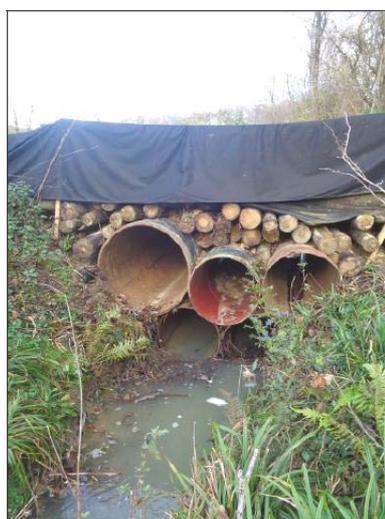
*Gainés métalliques recouvertes d'un platelage en rondins de bois*
