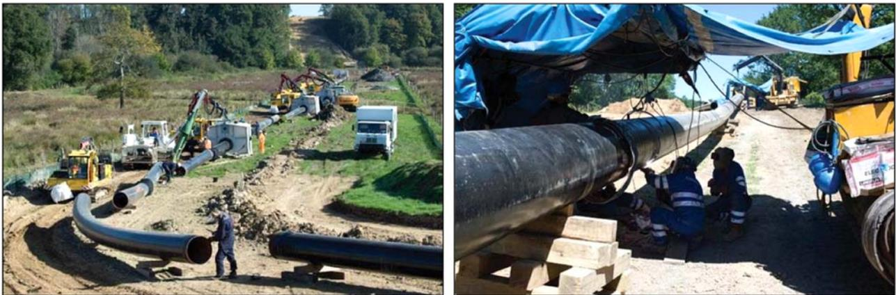
*Cirque de soudure de ligne composé de plusieurs cabines de soudage*
