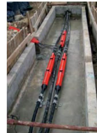
Figure 6 : Exemple de chambre de jonction
