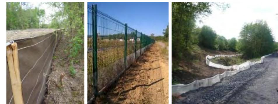
Exemple de différentes clôtures provisoires anti-amphibiens
