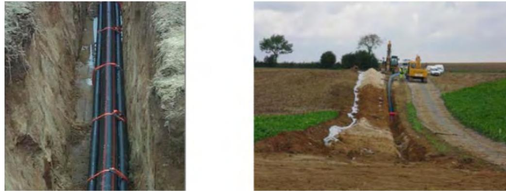
Figure 4 : Exemple de pose en milieu agricole
